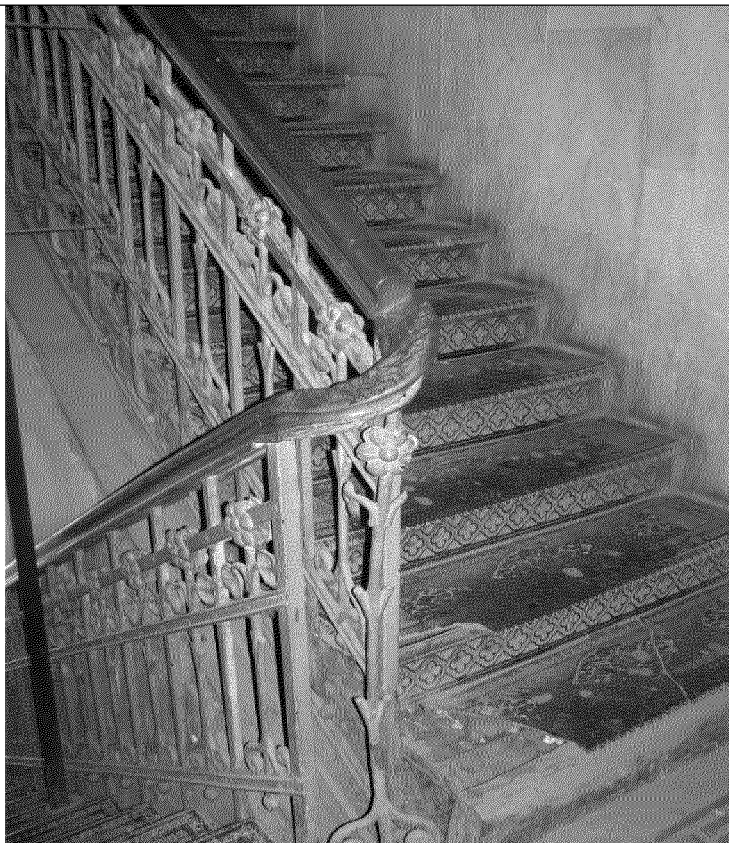
внутренняя междуэтажная парадная двухмаршевая чугунная лестница
