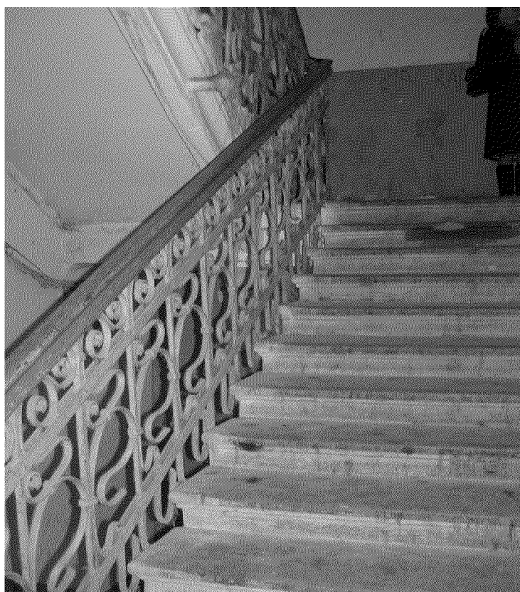
внутренняя междуэтажная парадная двухмаршевая железобетонная лестница
