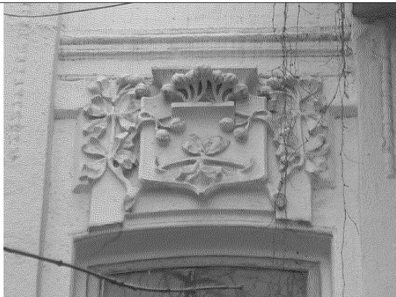
надоконные вставки на раскреповках в уровне второго этажа;
