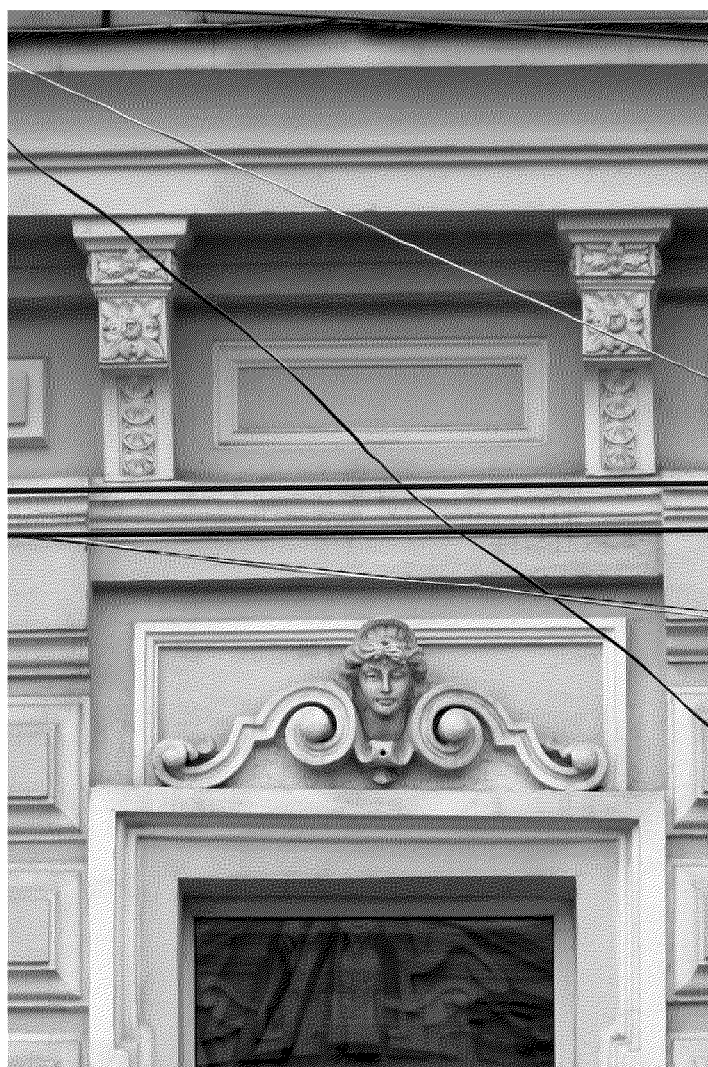
фрагмент декора оконного проема в уровне второго этажа;
