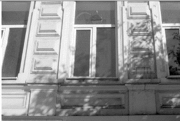
фрагмент южного фасада
