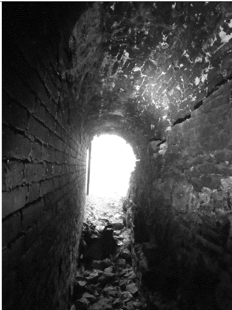
объект по адресу: ул. Береговая, 51, литер Г (подземная галерея)
