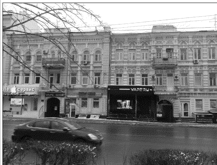
главный северный фасад объекта культурного наследия
