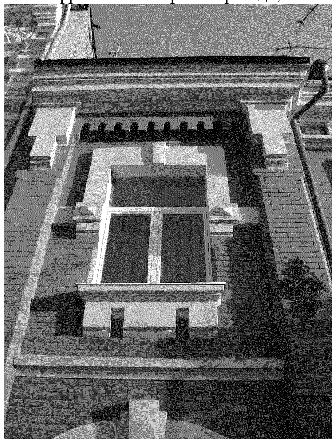
фрагмент восточной раскреповки;
