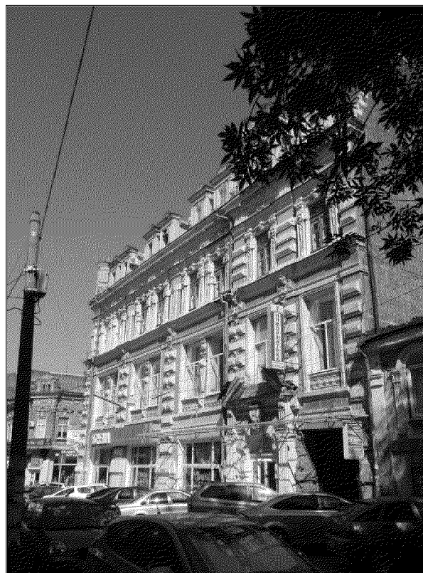
южный фасад объекта культурного наследия;
