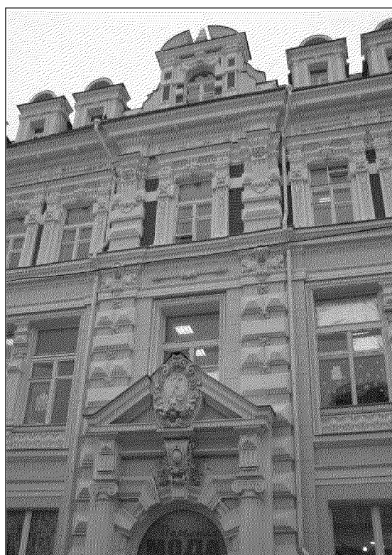
центральная раскреповка западного фасада объекта культурного наследия;
