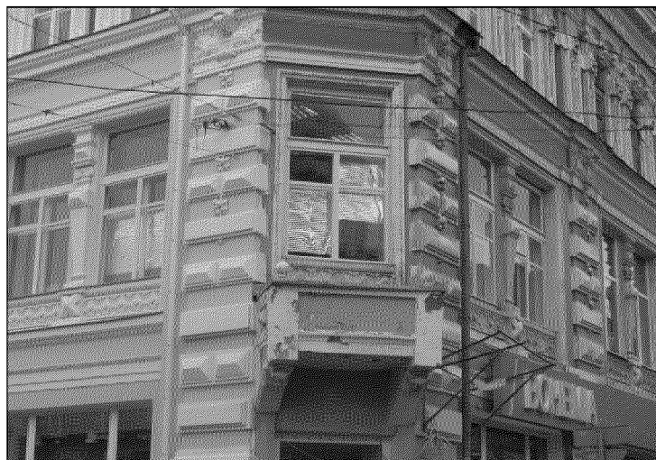
фрагмент срезанного в плане юго- западного углового объема объекта культурного наследия;
