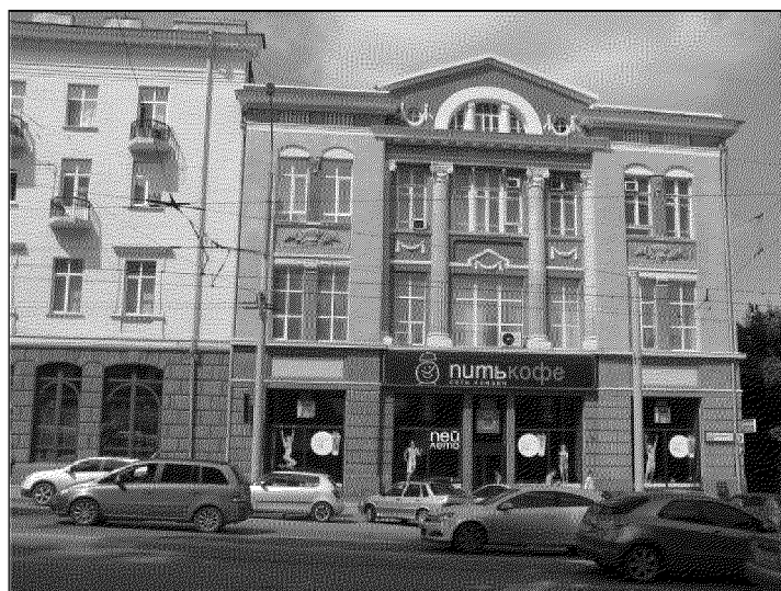
парадный восточный фасад объекта культурного наследия;
