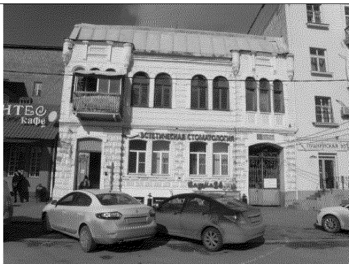
главный южный фасад
