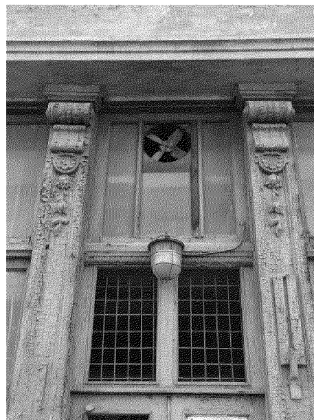
первоначальная расстекловка центрального входа
