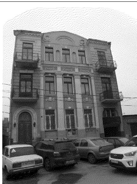
главный северный фасад
