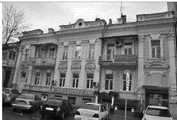
главный северный фасад
