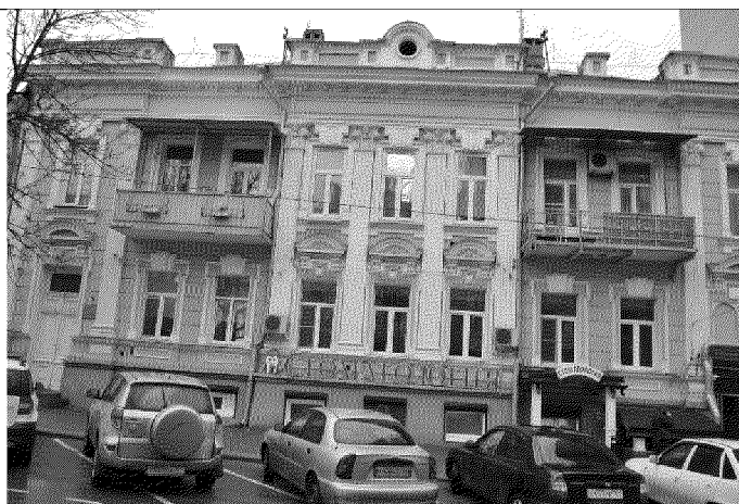
главный северный фасад
