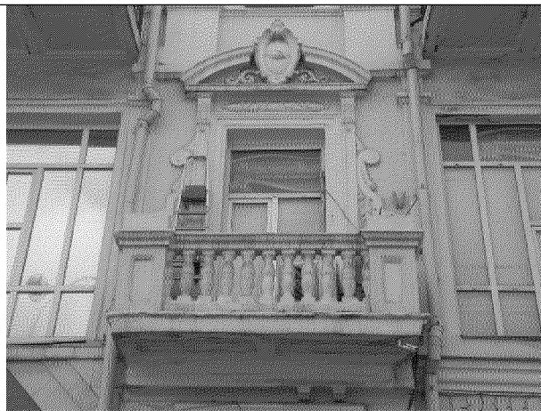
балкон и оформление оконного проема в уровне второго этажа северного фасада
