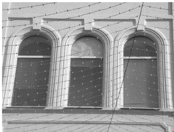
оформление оконных проемов в уровне третьего этажа на западном фасаде
