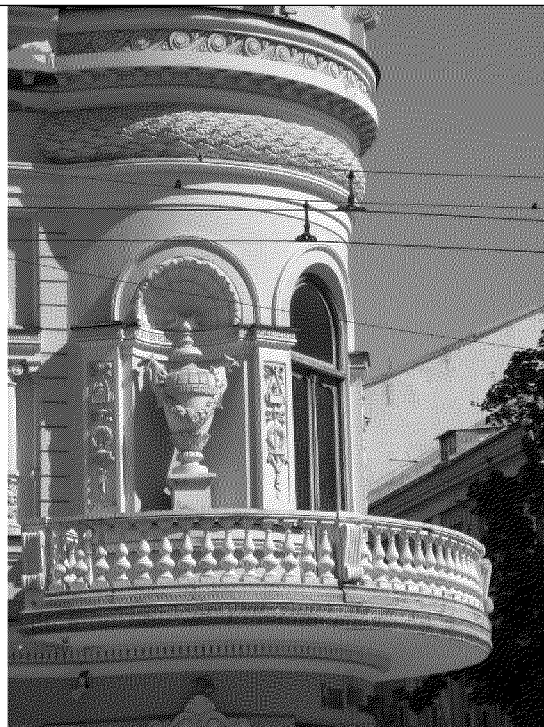
балкон второго этажа, расположенный на бельведере
