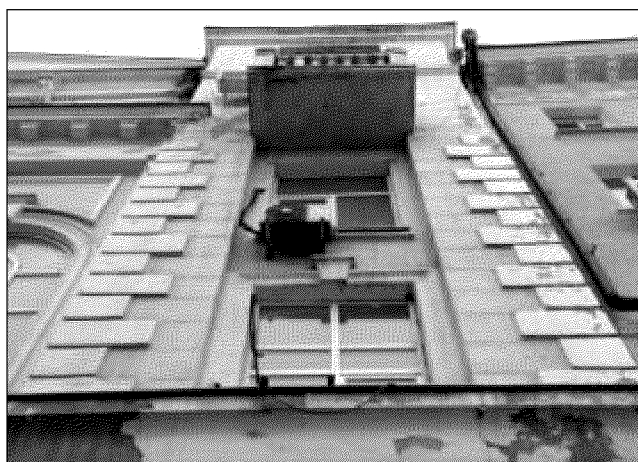
раскреповка главного фасада
