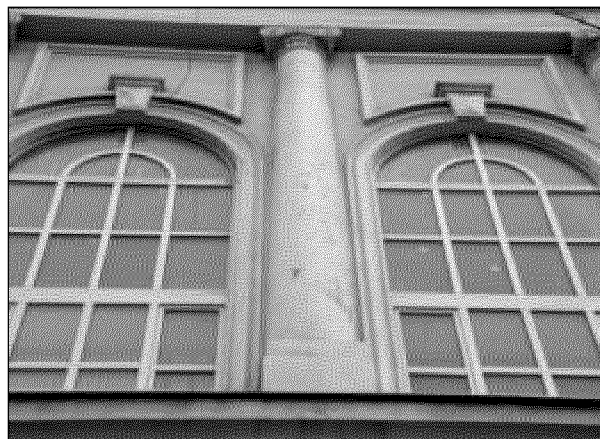
фрагмент главного фасада(арочные окна второго этажа)
