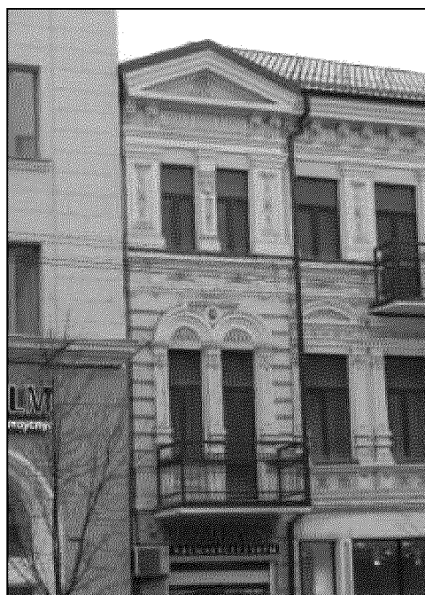
фрагмент главного северного фасада (крайняя восточная раскреповка)
