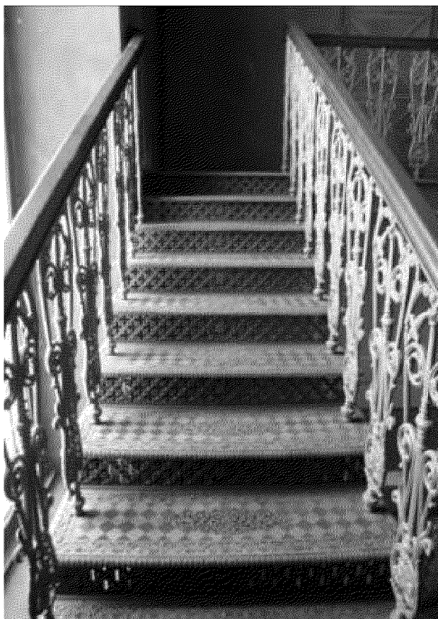
внутренняя металлическая лестница на хоры
