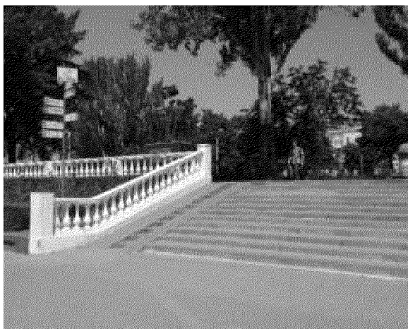
каменная лестница и балюстрада ограждения северного входа в объект культурного наследия
