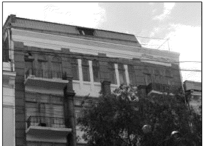
фрагмент главного северного фасада (архивное фото)
