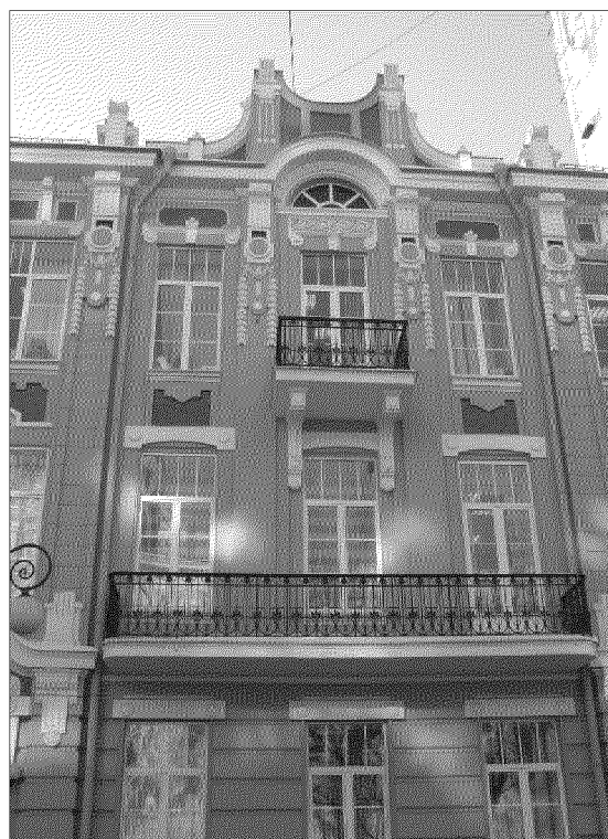
фрагмент главного северного фасада (центральная часть)
