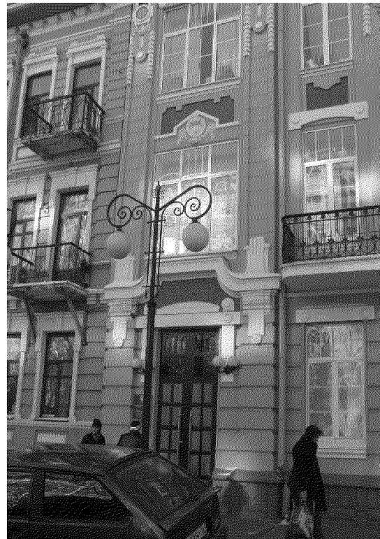
фрагмент крайней восточной раскреповки главного северного фасада (парадный вход)
