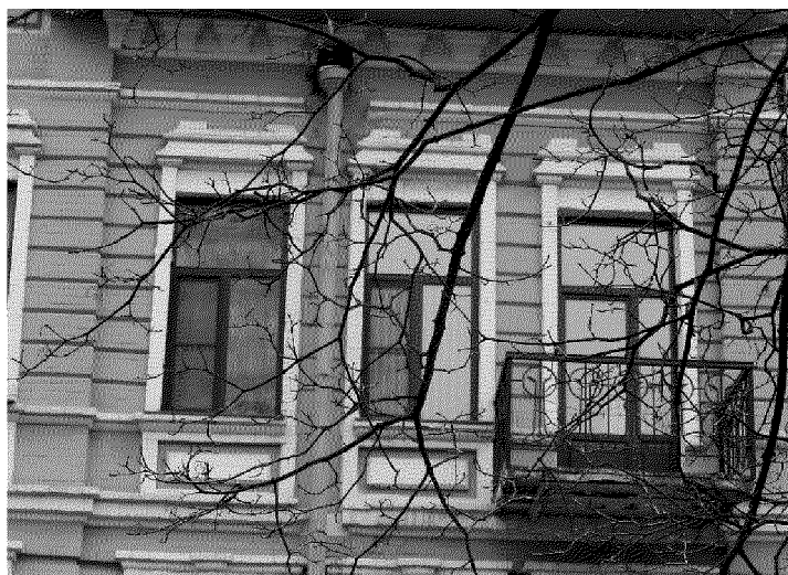
фрагмент главного северного фасада (ограждение балкона)
