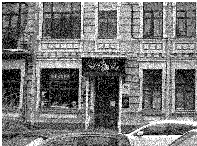
фрагмент главного северного фасада в уровне первого этажа
