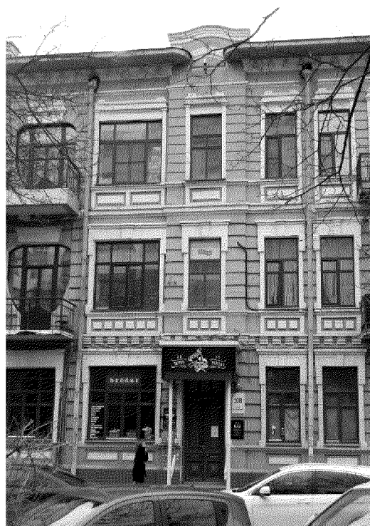
фрагмент главного северного фасада (центральная раскреповка)
