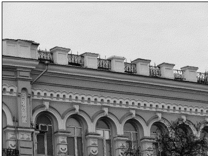
фрагмент главного восточного фасада в уровне верхнего этажа
