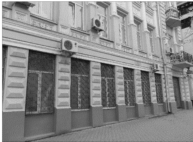
фрагмент главного восточного фасада в уровне первого яруса
