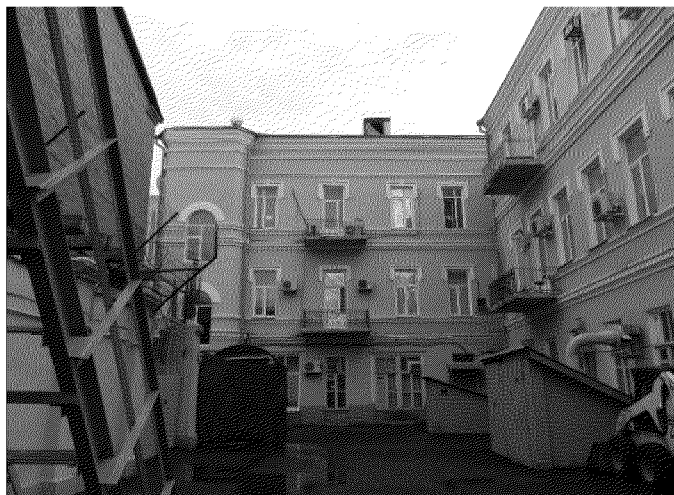
вид объекта культурного наследия с запада (дворовые фасады)
