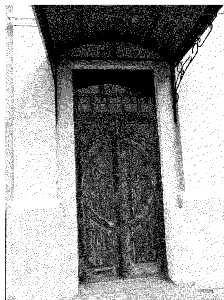
Крыльцо парадного входа объекта культурного наследия, литеры п/Б, Б, п/Б1, Б1, б4
