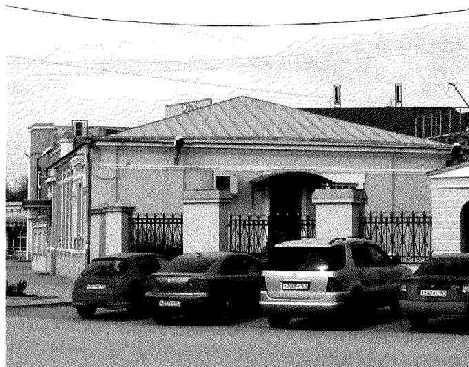
Вид объекта культурного наследия с юго-востока, литеры.п/Б, Б, п/Б1, Б1, б4;
