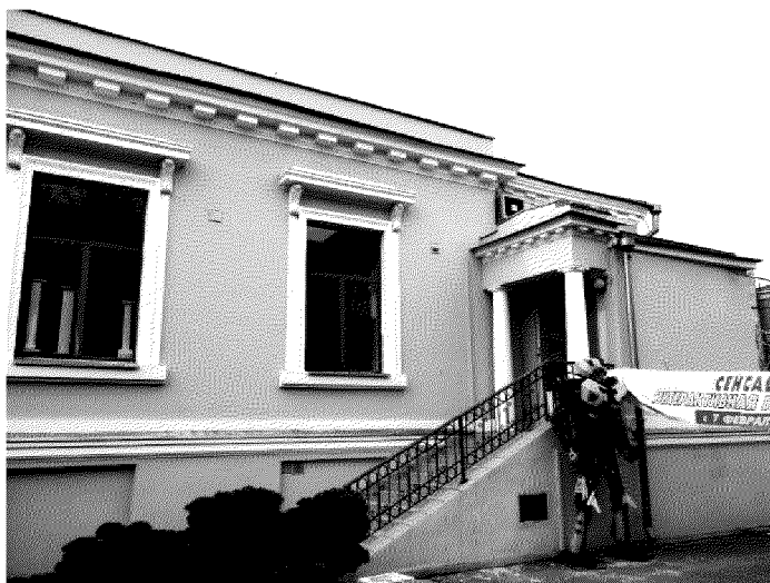
крыльцо восточного фасада объекта культурного наследия, литеры п/А, А, а
