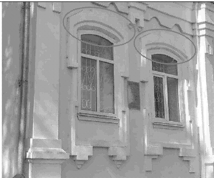
Лучковая перемычка оконных проемов
