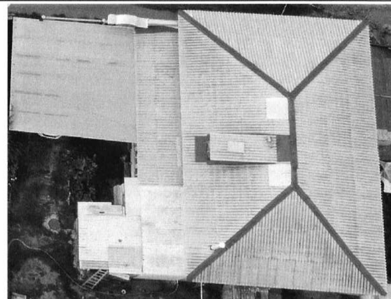
Крыша объекта культурного наследия.
