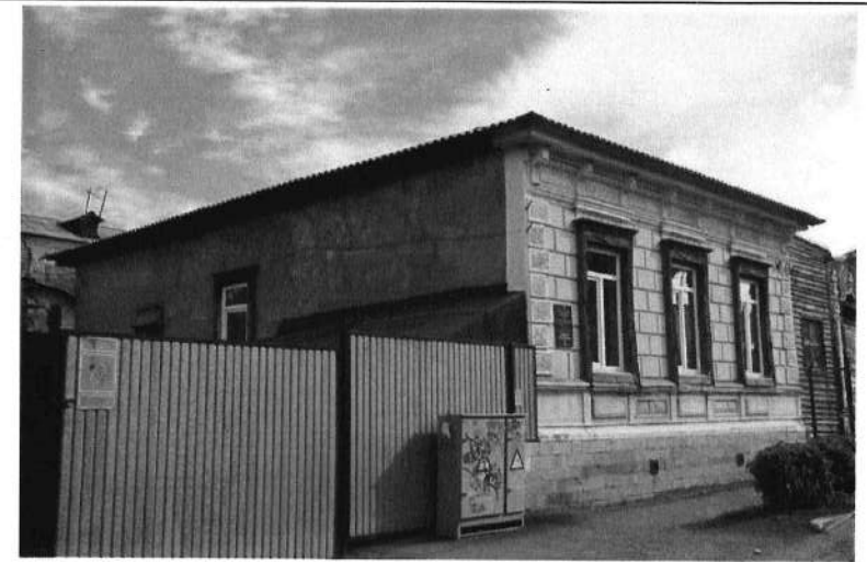
Вид на фрагмент западного фасада объекта культурного наследия.
