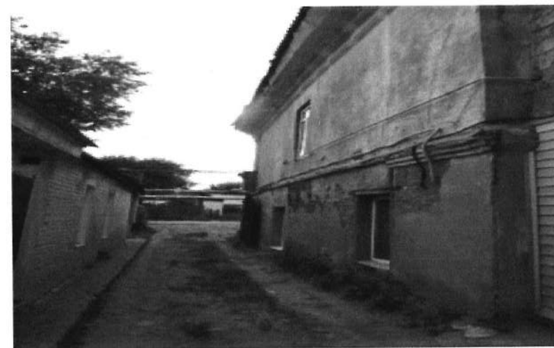
Фото с северо-запада.
