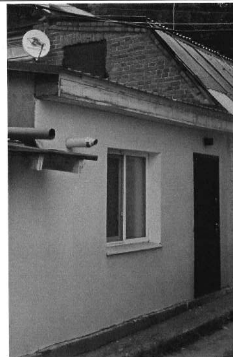
Западный фасад флигеля. Вид с северо-запада.
