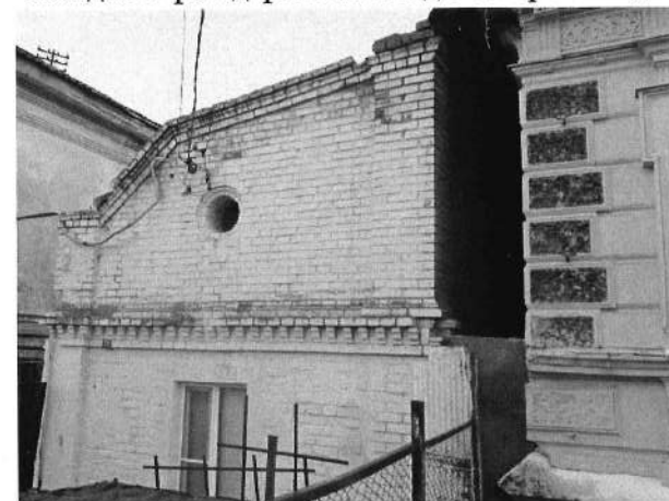
Вид на фрагмент северного фасада флигеля.
