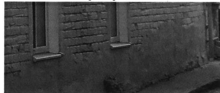
Фрагмент цоколя флигеля.
