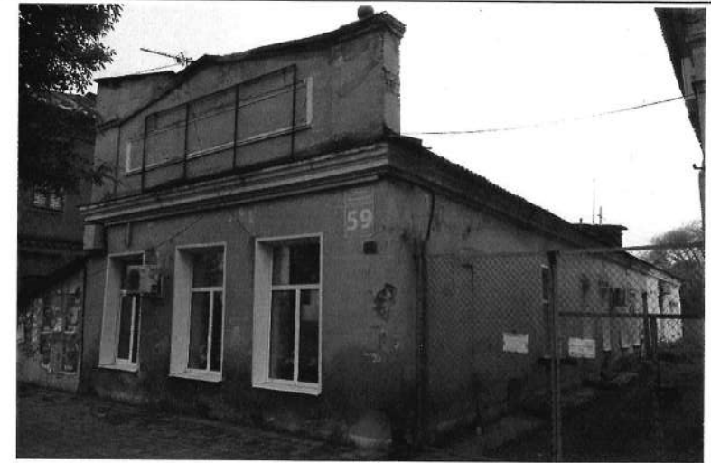
Восточный и северный фасады флигеля с лавкой.
