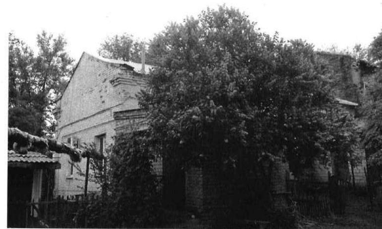
Вид на восточный и южный фасады здания служб с юго-запада (со двора).
