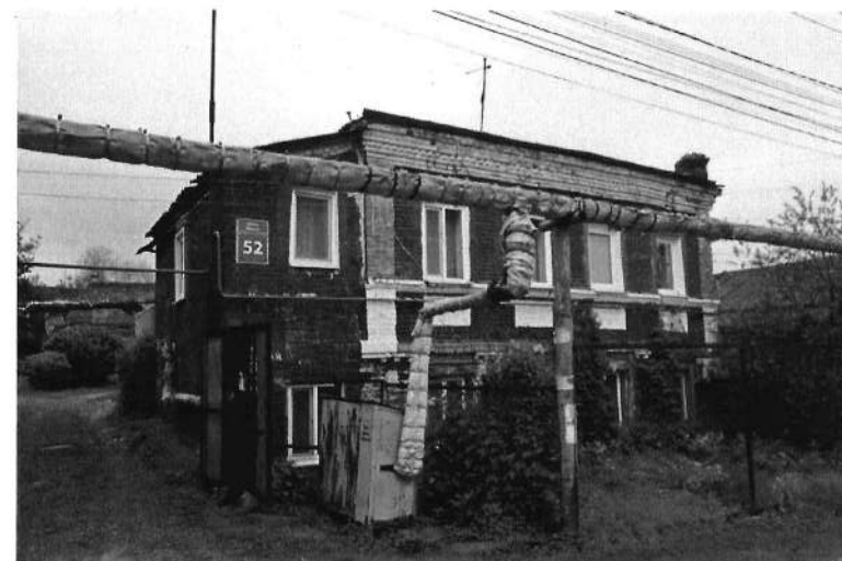
Вид на западный фасад флигеля с северо-запада.
