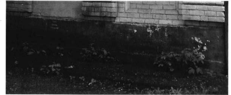
Цоколь здания служб.
