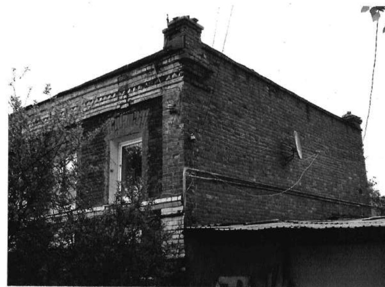
Вид на южный фасад флигеля с юго-запада.
