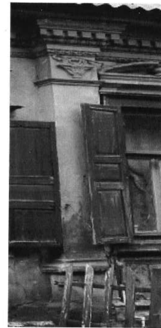
Рядовая пилястра. Северный фасад.
