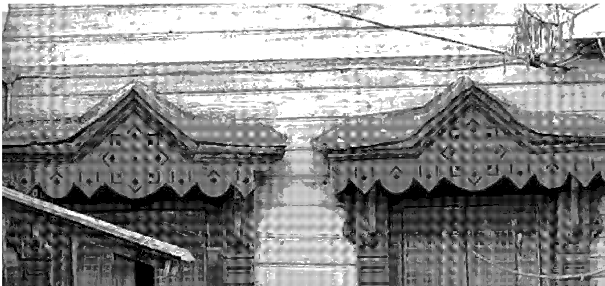
9. Детали окон первого этажа северного фасада.
