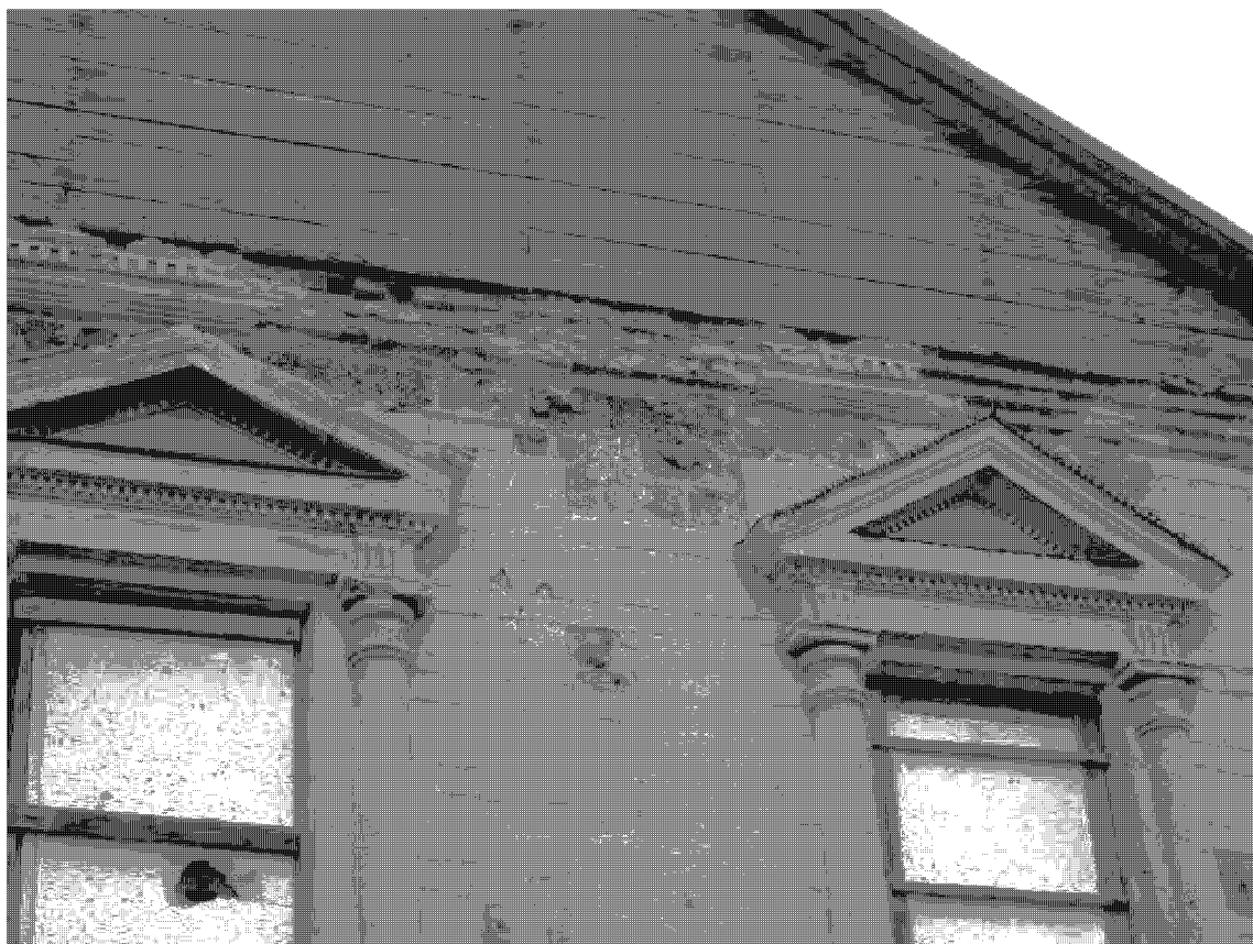
7. Фрагмент западного фасада здания. Обрамление окон второго этажа здания. Вид с запада.
