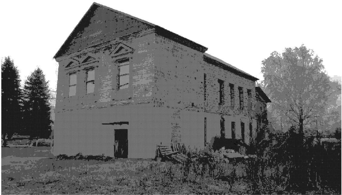
4. Западный и южный фасады здания. Вид с юго-запада.
