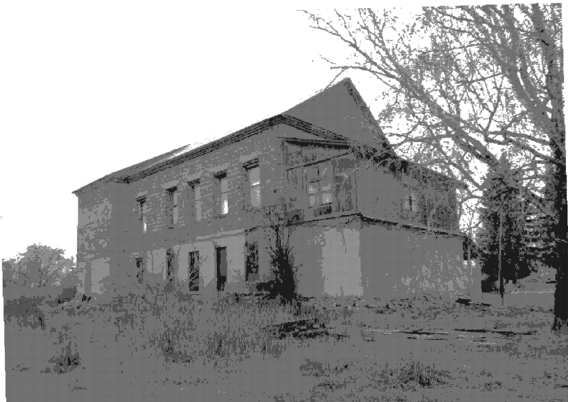
6. Южный и восточный фасады здания. Вид с юго-востока.
