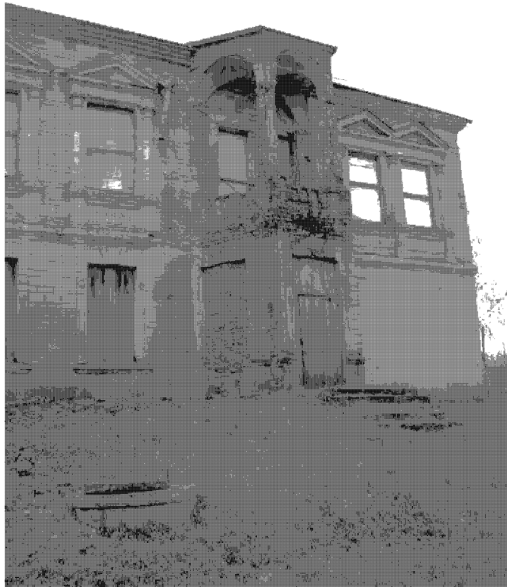
2. Фрагмент северного фасада здания. Вид с северо-востока.
