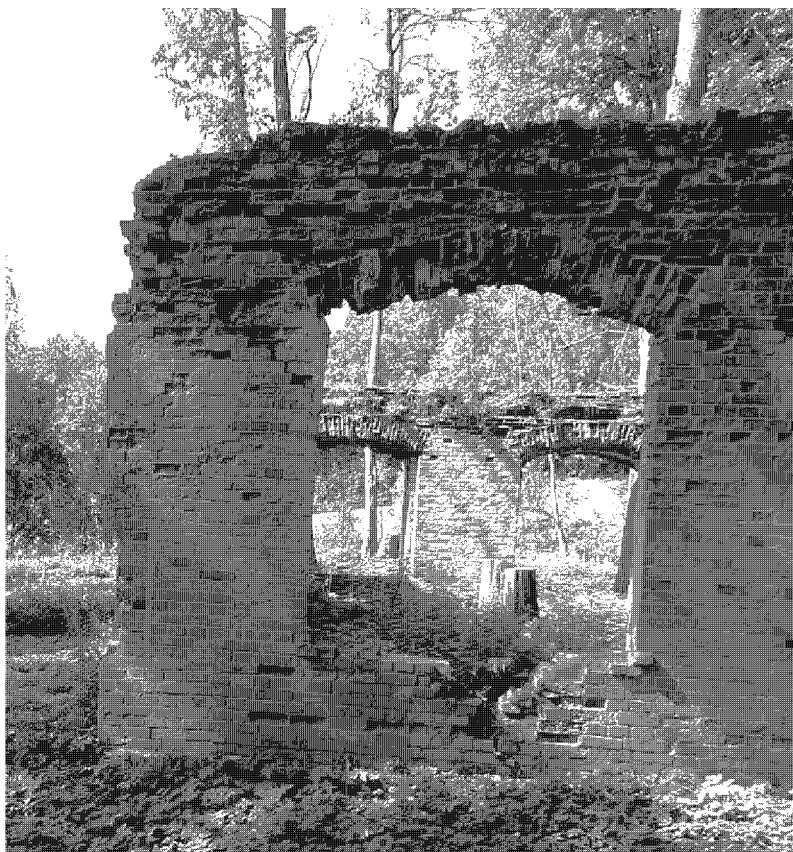
8. Оконный проем в южной части восточного фасада Объекта.
