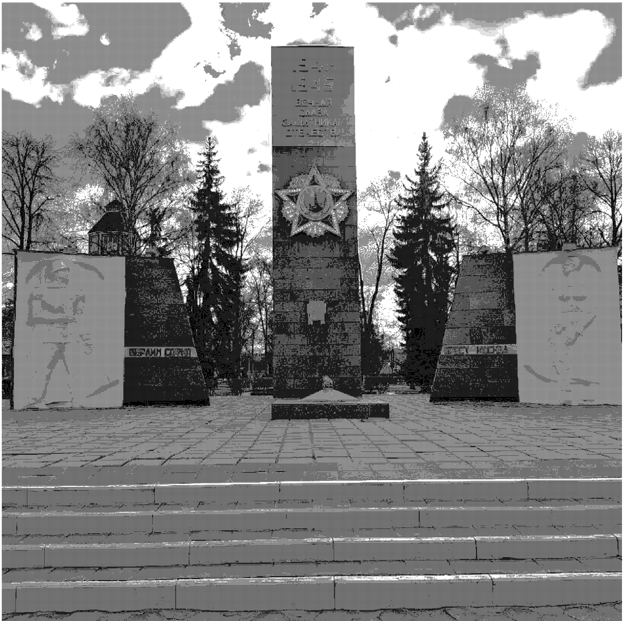
1. Вид на Объект со стороны улицы Советская города Ногинск, вид с северо-запада.
