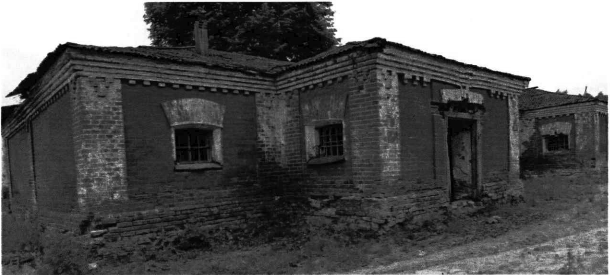
6. Фрагмент северного фасада.
