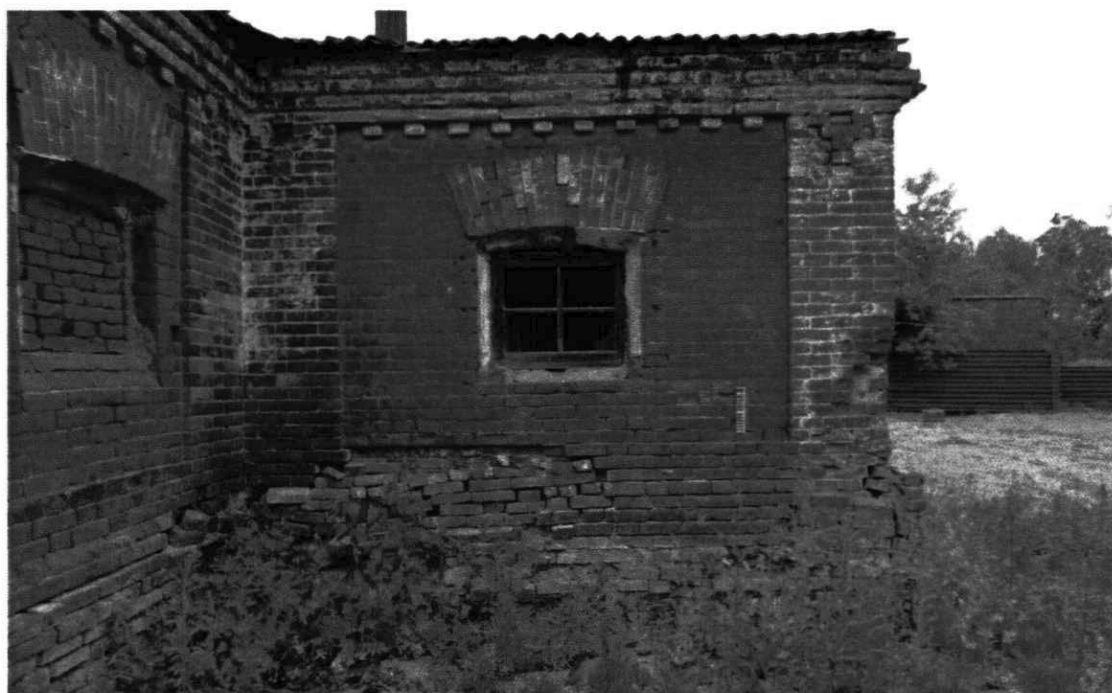
4. Фрагмент южного фасада.
