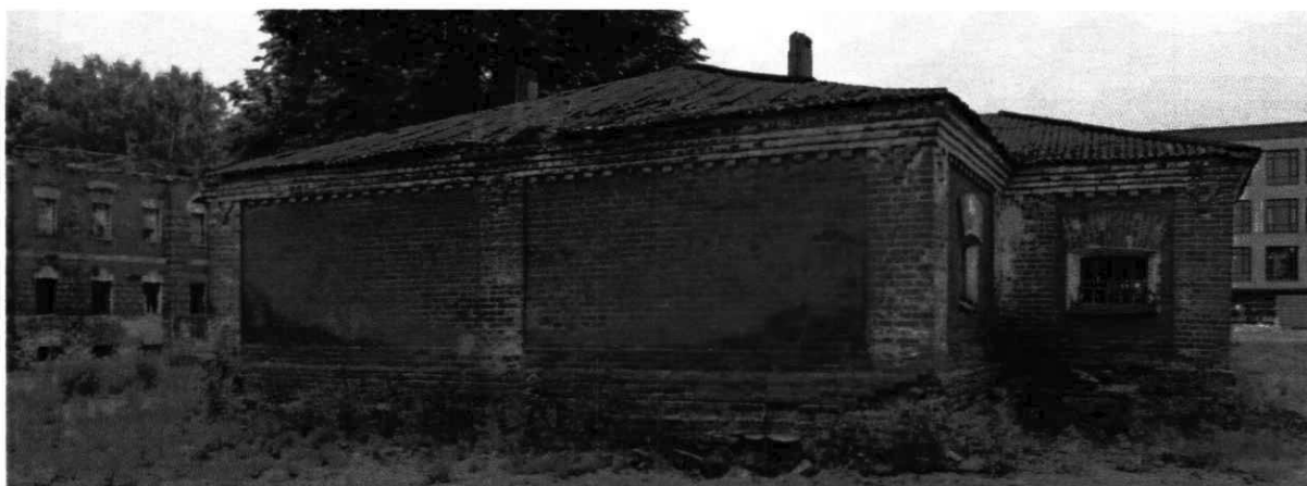
5. Общий вид восточного фасада.
