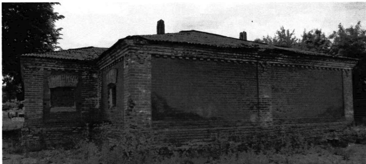
3. Фрагмент южного фасада.
