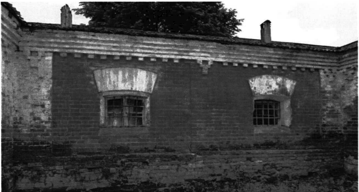
7. Фрагмент северного фасада.
