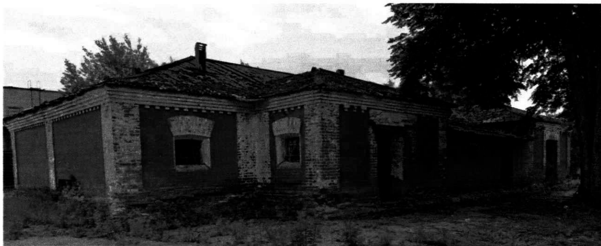
1. Общий вид западного и южного фасадов. Вид на северо-восток.
