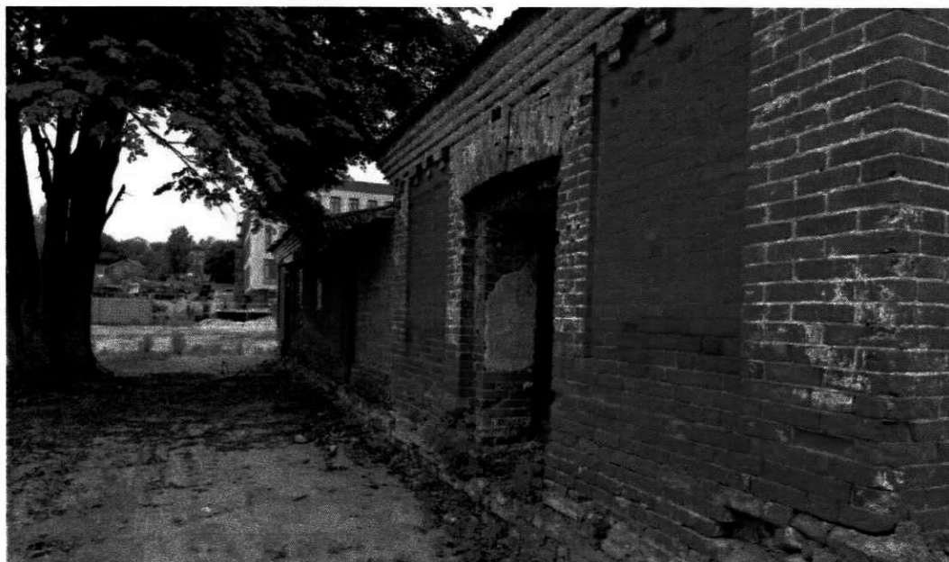
2. Фрагмент южного фасада.
