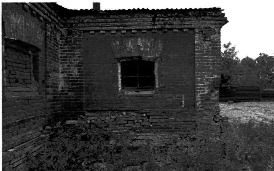
4. Фрагмент южного фасада.
