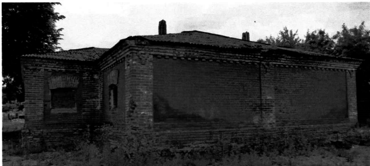
3. Фрагмент южного фасада.
