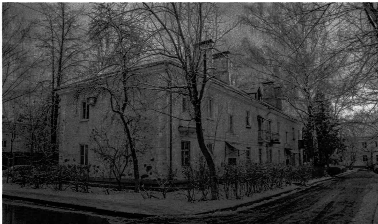
3. Вид на здание с юго-востока.
