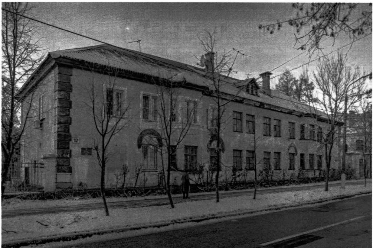
1. Вид на здание с юго-востока.
