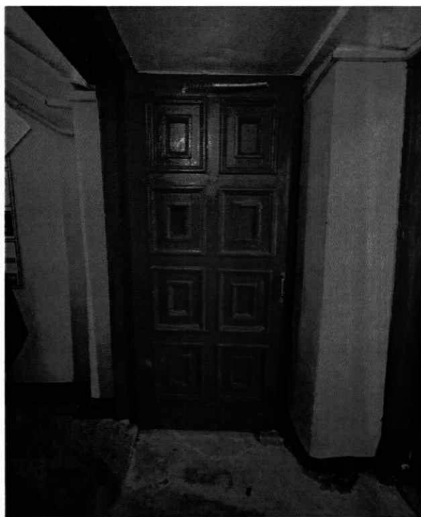
3. Входная дверь в здании, первый этаж.
