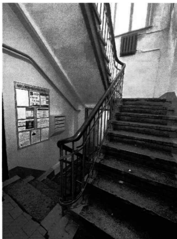
5. Лестница в здании, первый этаж.
