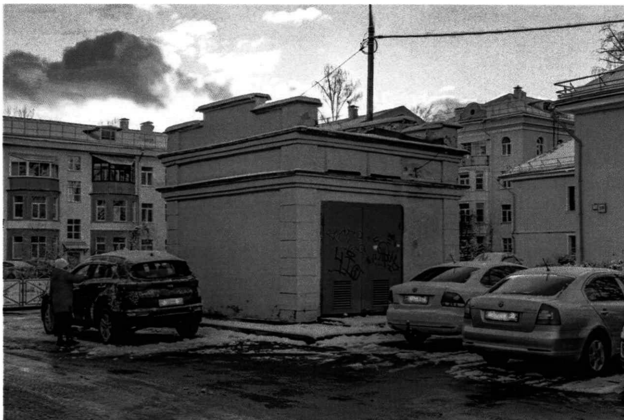
23. Трансформаторная подстанция №1. Вид с северо-востока.
