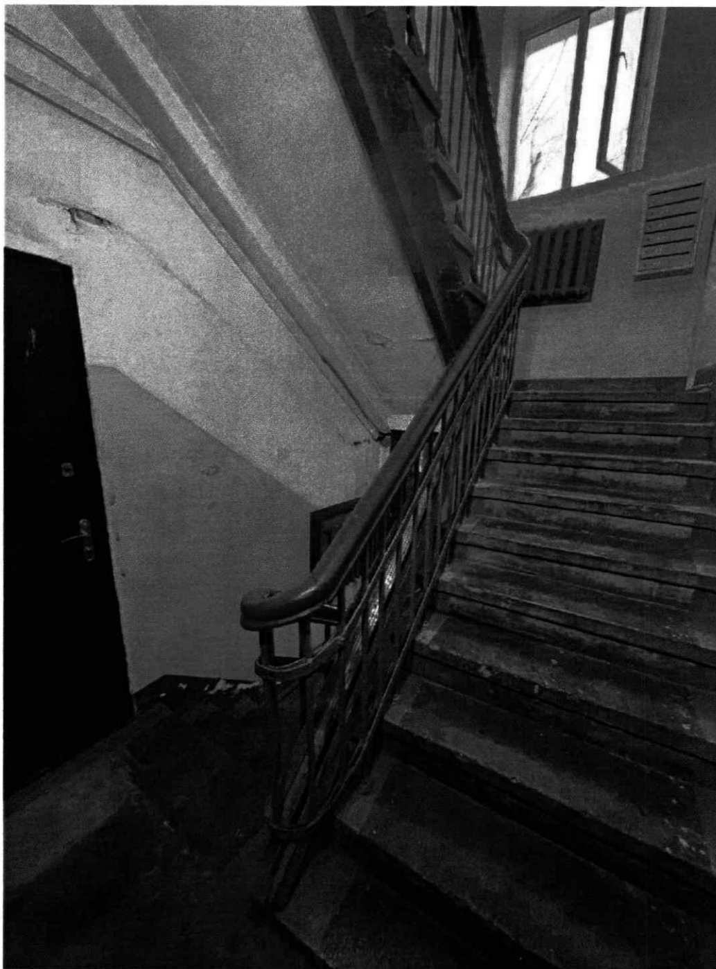
4. Лестница в здании, первый этаж.
