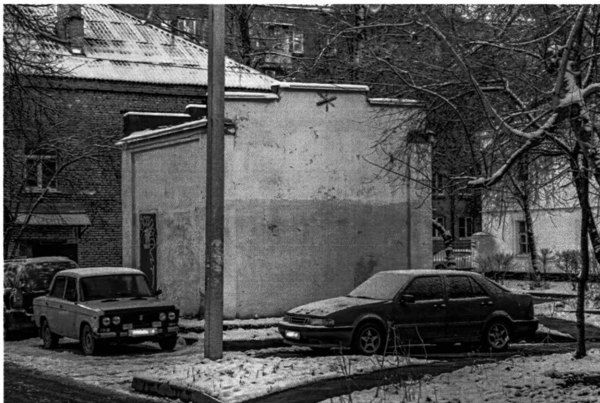
24. Трансформаторная подстанция №2. Вид с юго-запада.
