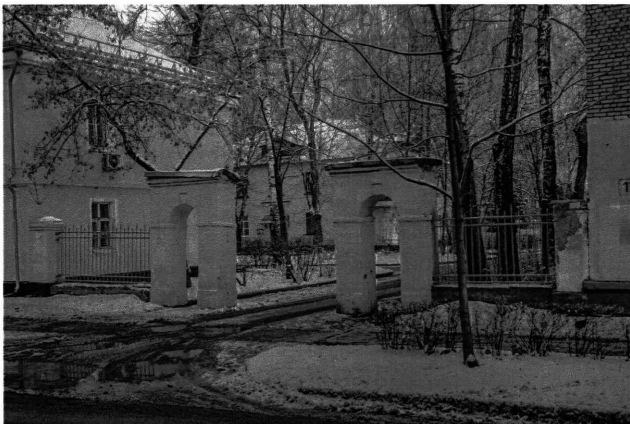
1. Ограда между домами №13 и №17 по улице Карла Маркса, вид с запада.
