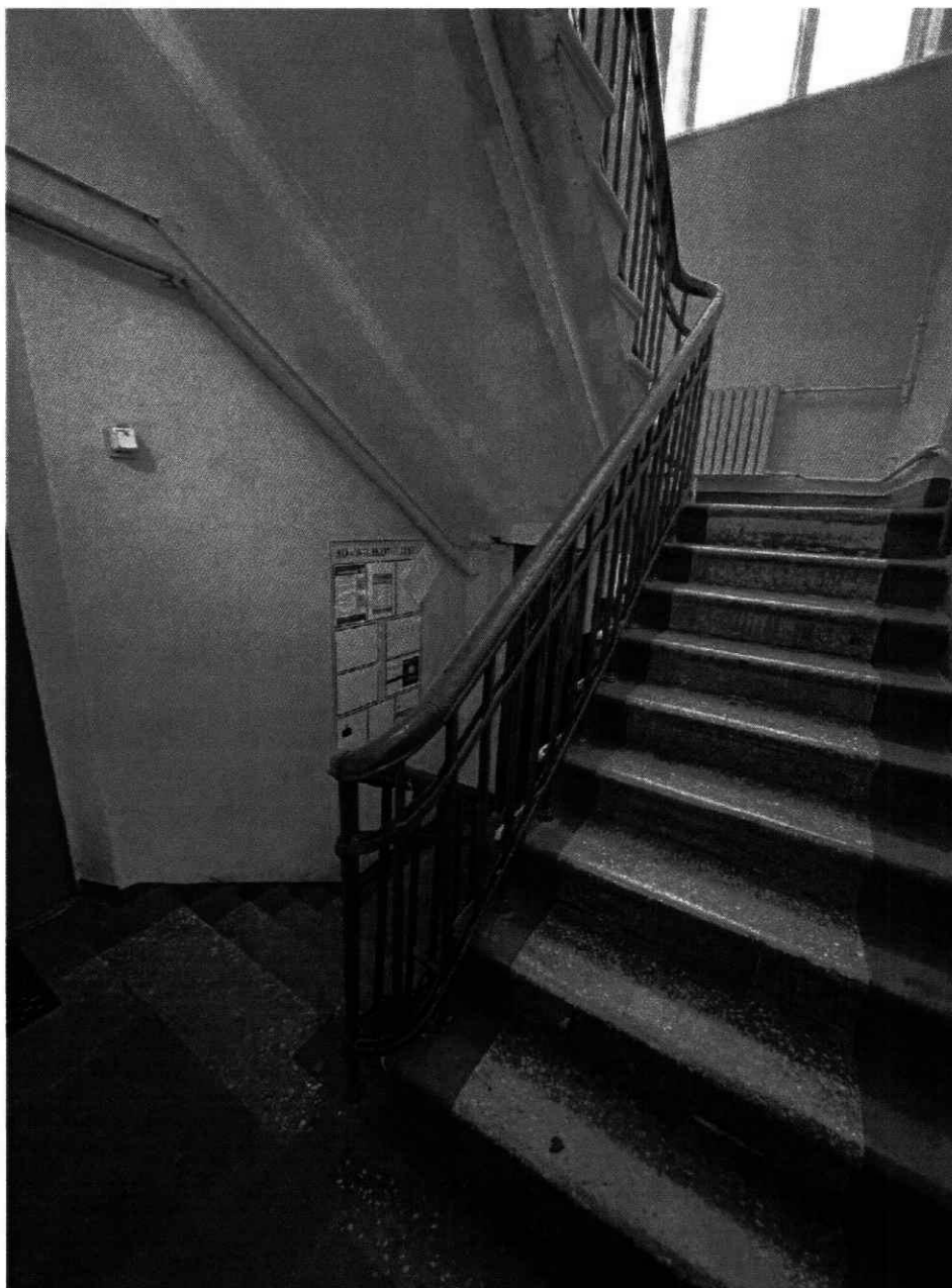
4. Лестница в здании, первый этаж.
