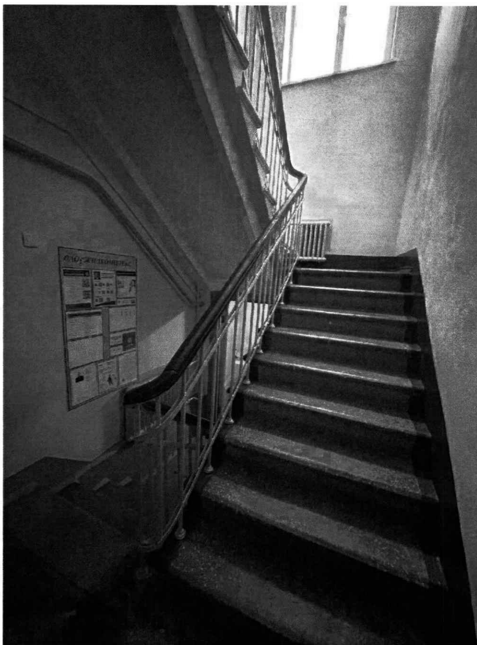
4. Лестница в здании, первый этаж.
