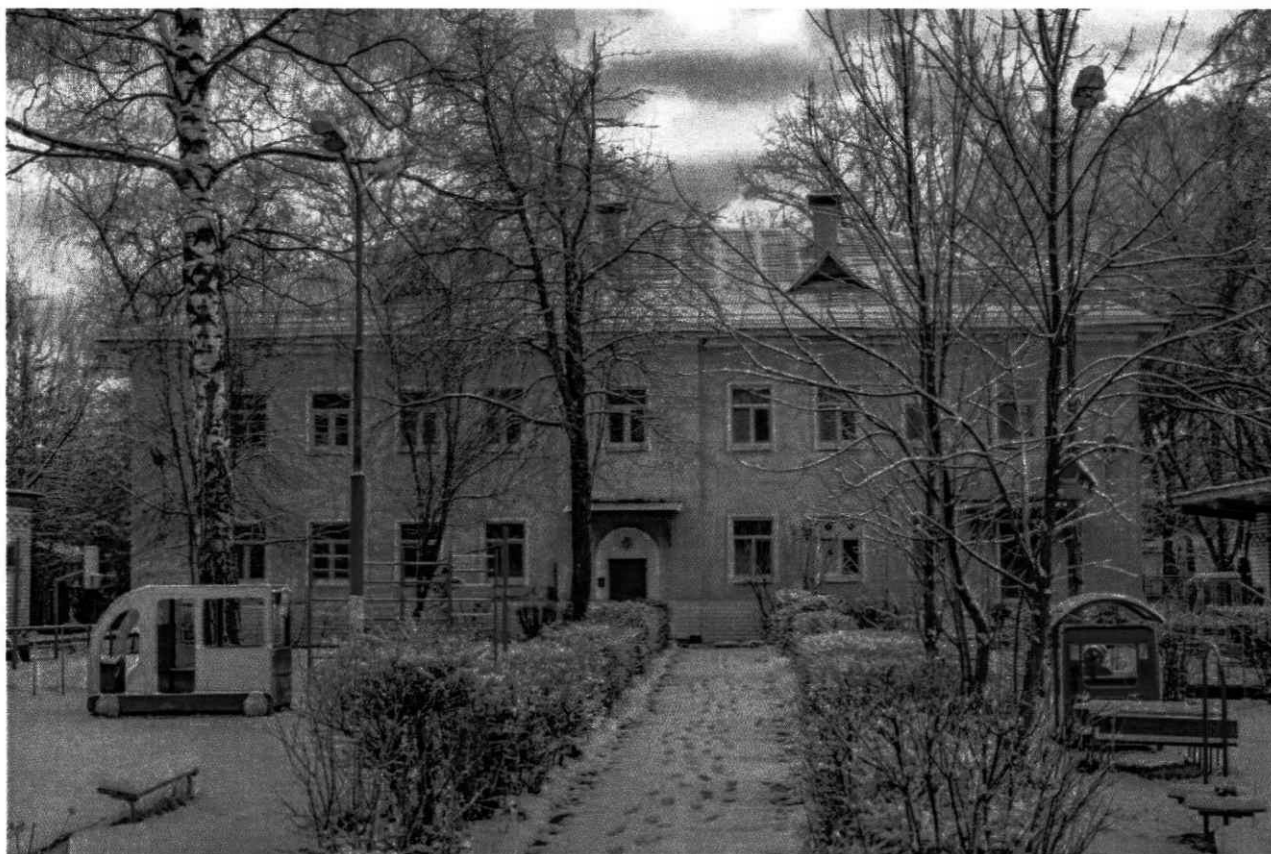
1. Вид на здание с севера.
