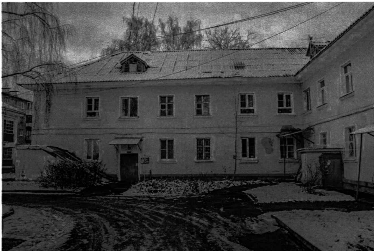
2. Вид на здание с юга.
