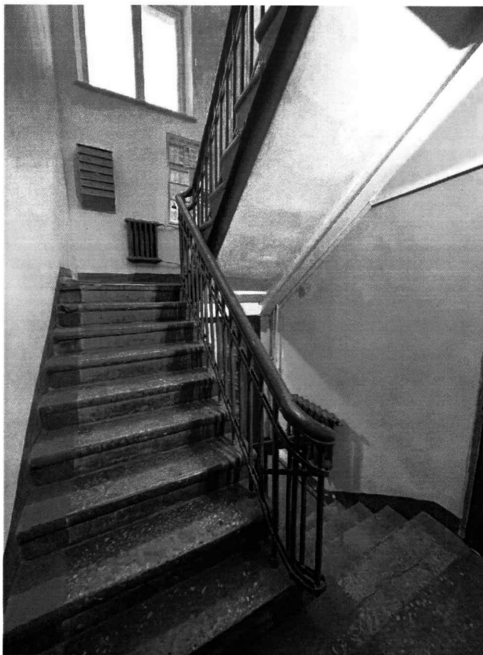
4. Лестница в здании, первый этаж.
