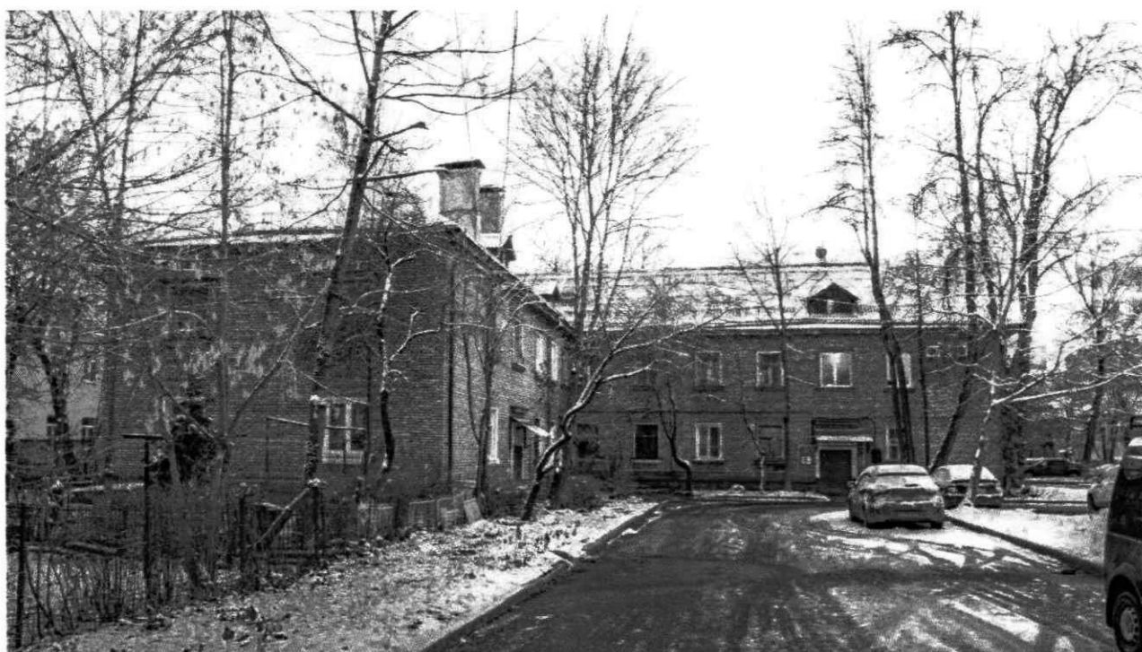
1. Вид на здание с севера.
