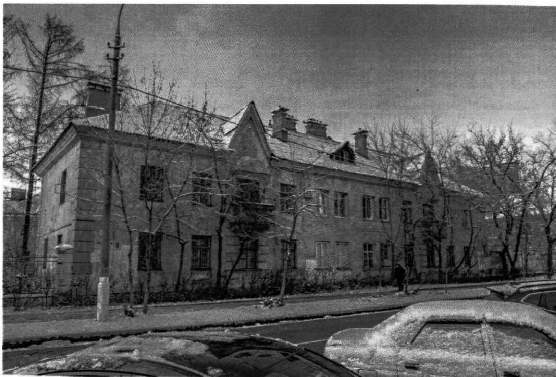
2. Вид на здание с юго-востока.
