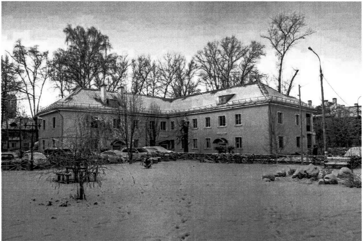
1. Вид на здание с юго-востока.
