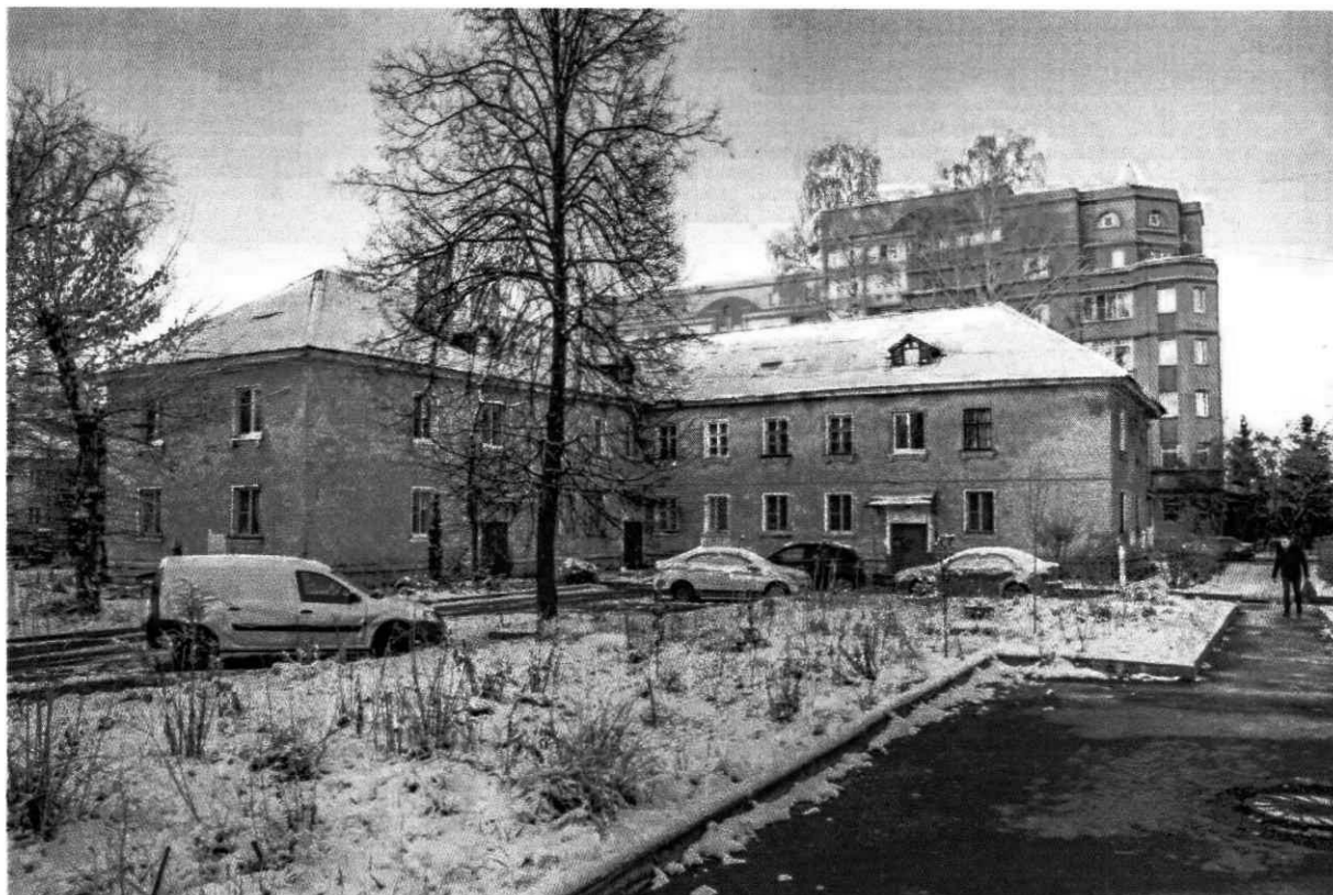
2. Вид на здание с юго-востока.
