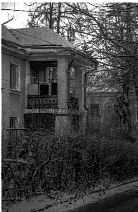
3. Вид на здание с запада.
