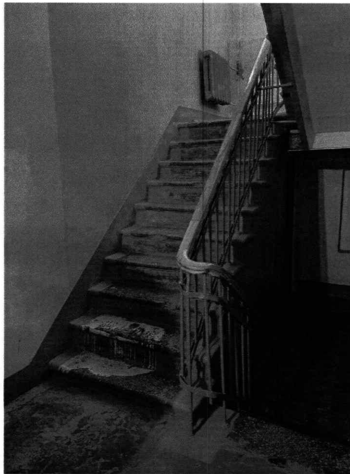
3. Лестница в здании, первый этаж.
