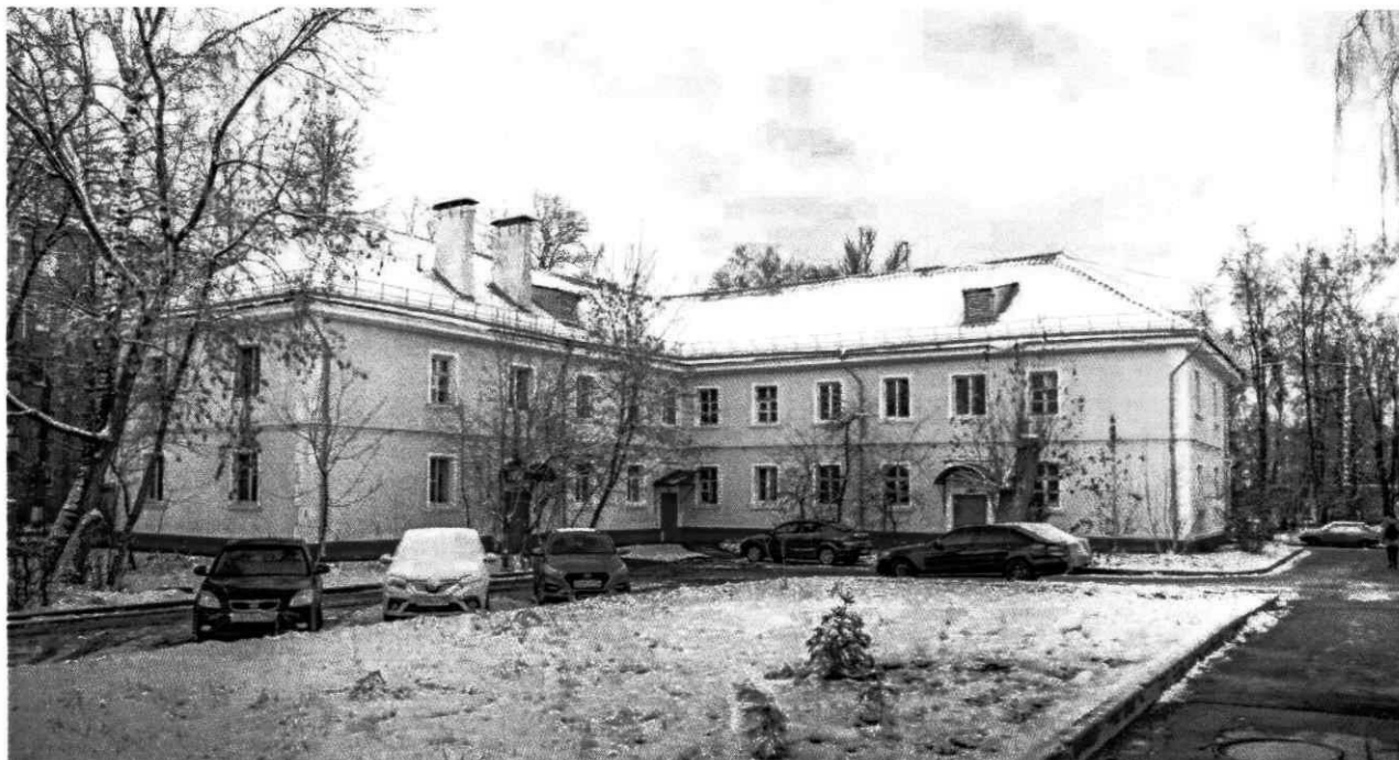
2. Вид на здание с юга.
