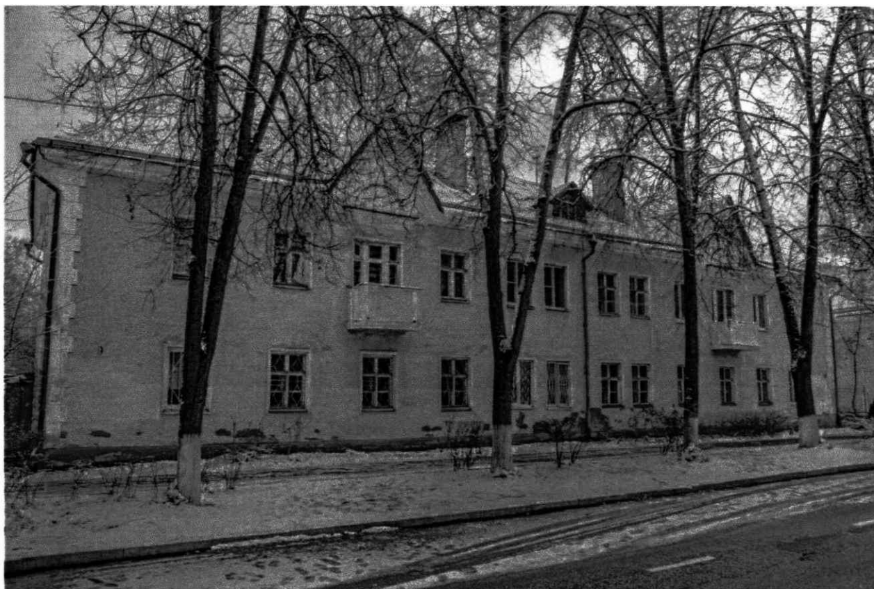
2. Вид на здание с запада.
