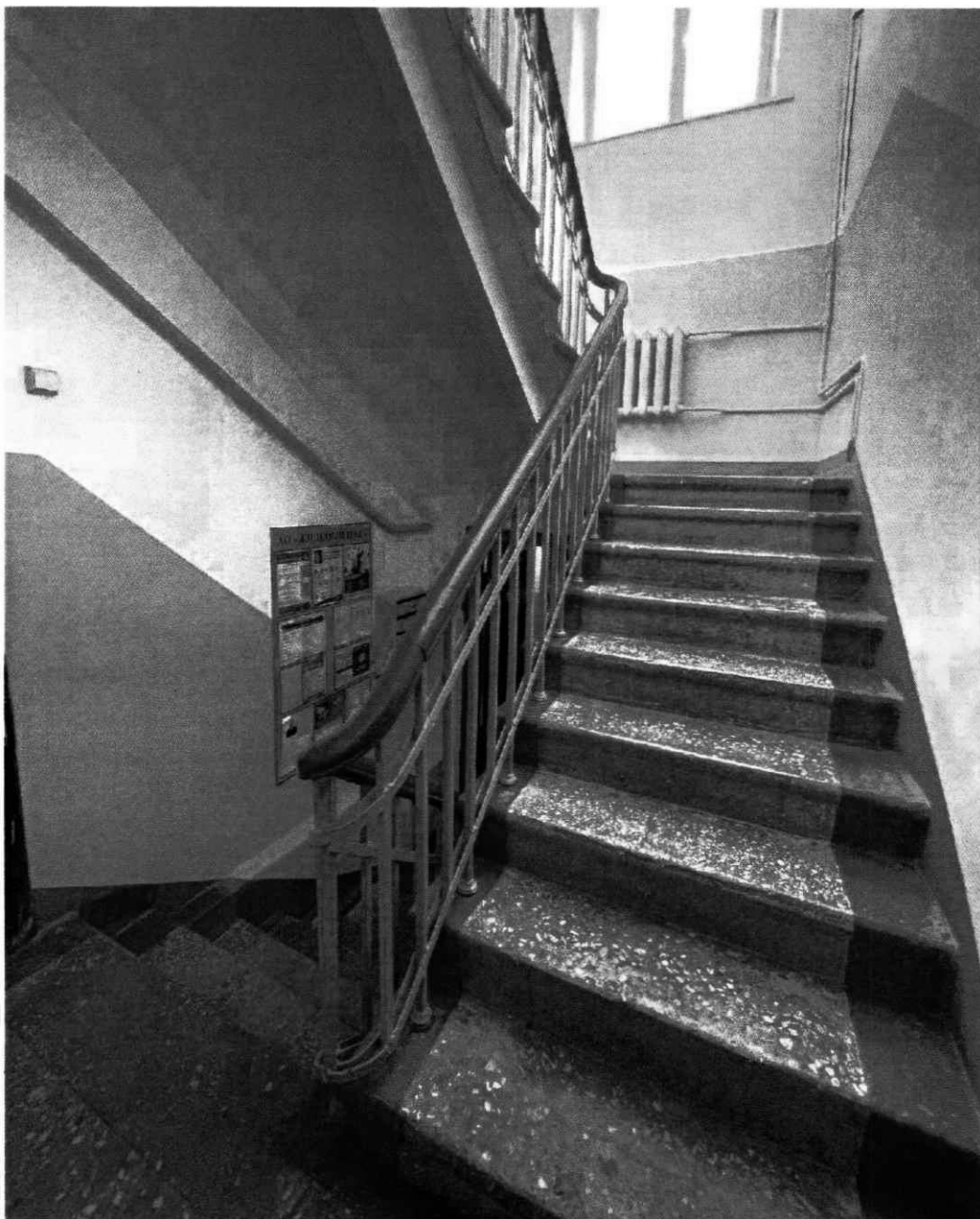
4. Лестница в здании, первый этаж.
