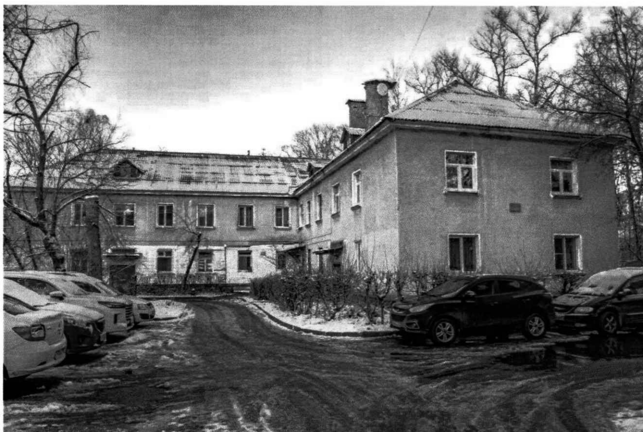
1. Вид на здание с юга.
