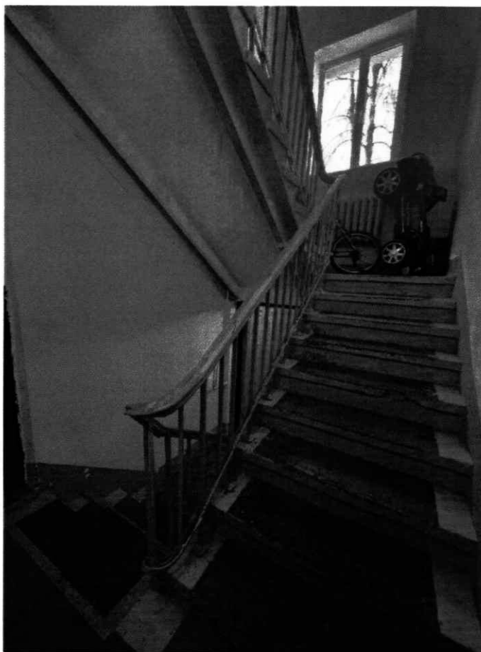
3. Лестница в здании, первый этаж.
