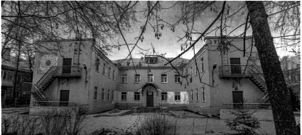
3. Вид на здание с юга.
