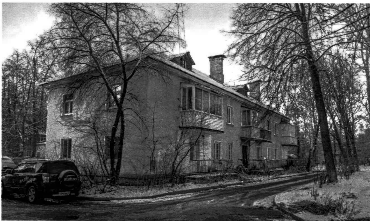
3. Вид на здание с юго-востока.
