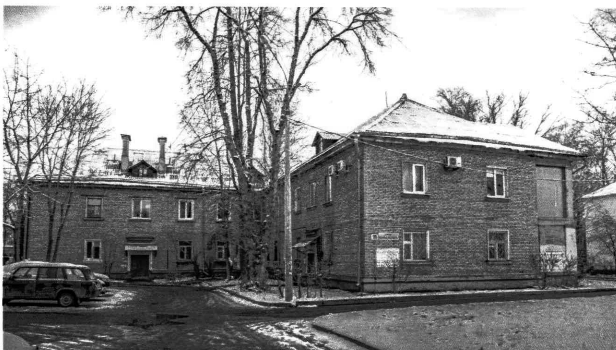
2. Вид на здание с запада.
