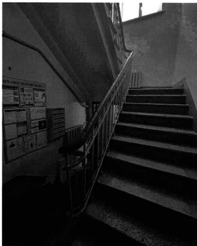
3. Лестница в здании, первый этаж.
