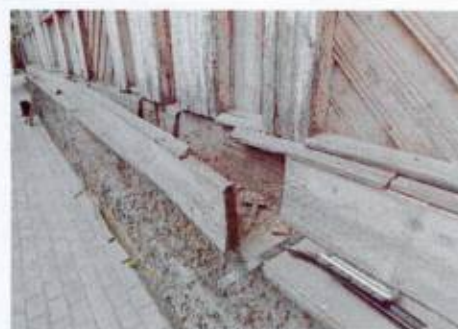
Фрагмент деревянного профилированного пояса над каменным цоколем
