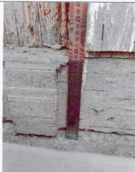
Фрагмент деревянного профилированного пояса над каменным цоколем
