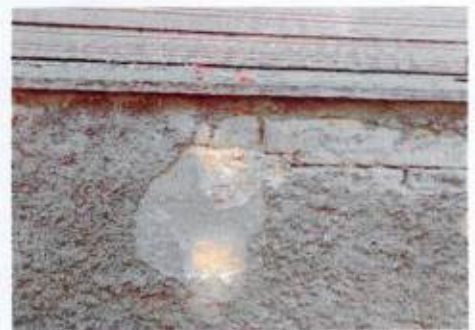
Фрагмент цоколя дворового фасада
