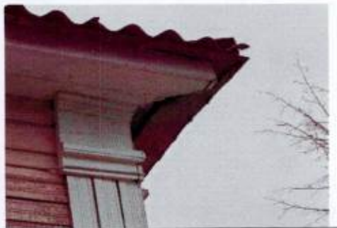
Деревянный антаблемент с гладким фризом и карнизом
