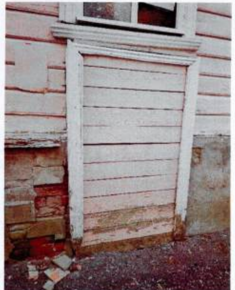
Забитый дверной проем. Северо-восточный дворовой фасад
