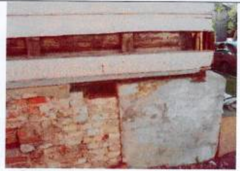
Фрагмент цоколя северного фасада
