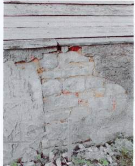
Фрагмент цоколя дворового фасада
