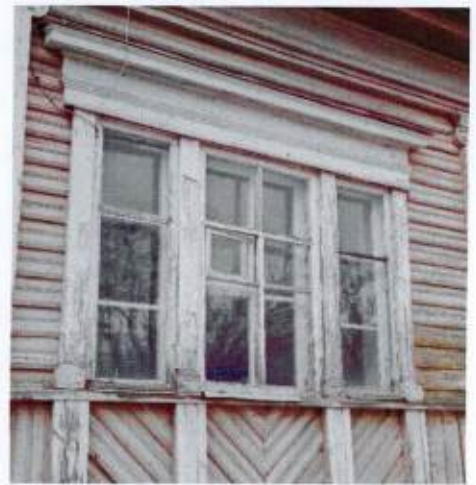
Оконный проем с заполнением. Лицевой фасад
