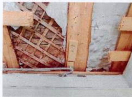
Вид на деревянное перекрытие 1-го этажа
