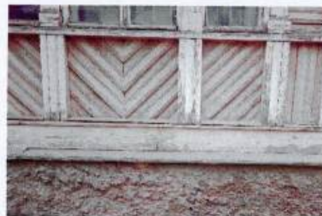
Вертикальные деревянные стойки в подоконном пространстве
