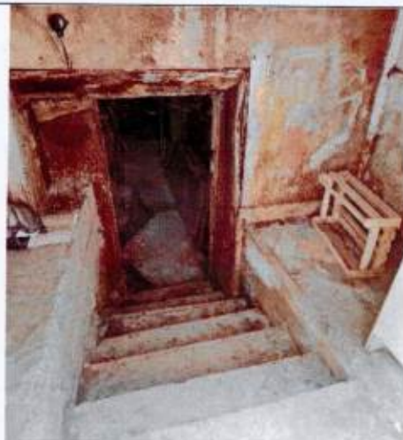
Дверной проем в цоколь. Дворовой фасад
