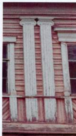
Деревянные парные канелированные пилястры
