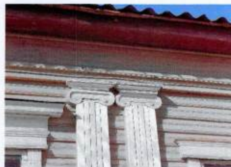
Деревянные парные канелированные пилястры (Фрагмент)
