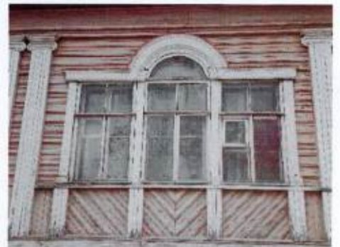
Оконный проем с заполнением. Лицевой фасад
