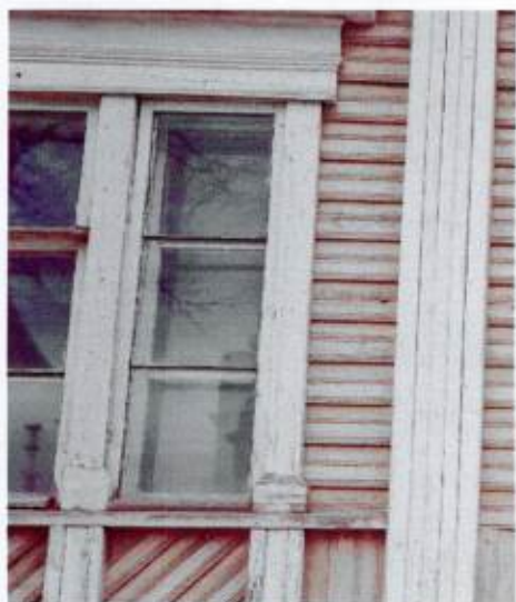
Деревянные оконные вертикальные наличники
