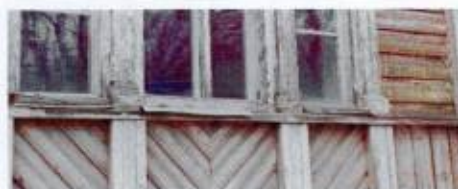
Деревянная подоконная тяга
