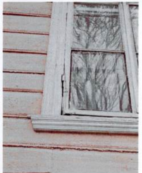
Фрагмент отделки дворового фасада деревянной профилированной доской
