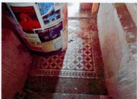
Отделки пола площадок главной лестницы (керамическая плитка)
