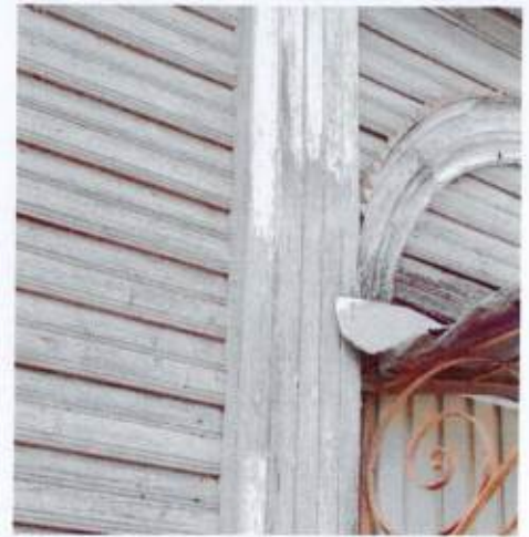
Фрагмент отделки лицевого фасада деревянной профилированной доской
