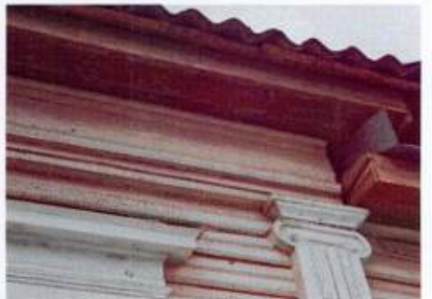
Деревянный антаблемент с гладким фризом и карнизом
