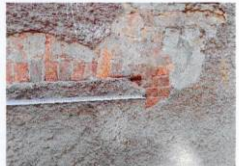
Фрагмент цоколя дворового фасада
