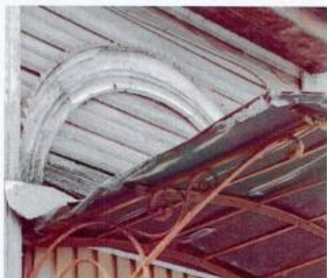
Деревянный арочный сандрик
