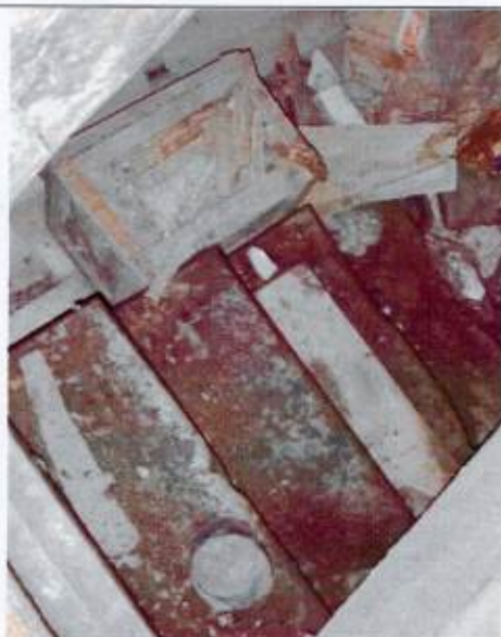
Каменные профилированные ступени малой лестницы
