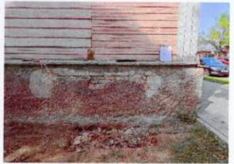
Фрагмент цоколя южного фасада
