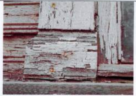
Деревянные оконные вертикальные наличники (фрагмент, база)
