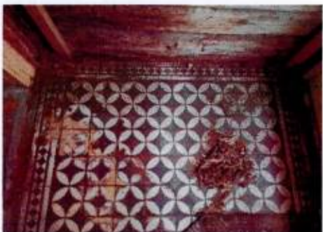
Отделки пола площадок главной лестницы (керамическая плитка)
