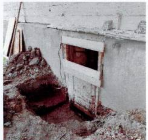
Дверной проем в цоколь. Северо-западный дворовой фасад
