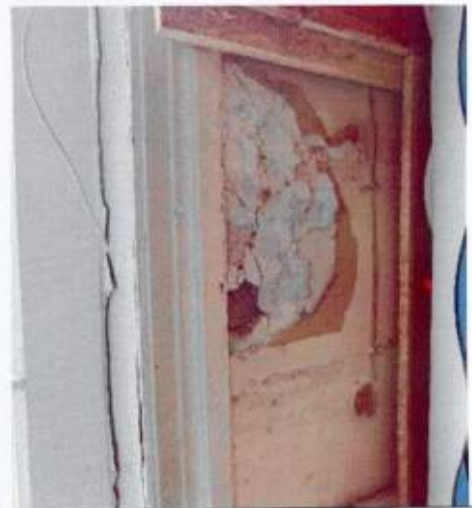
Фрагмент деревянного профилированного оконного наличника
