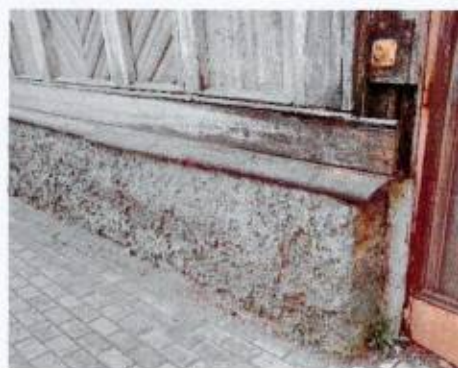
Деревянный профилированный отлив над каменным цоколем
