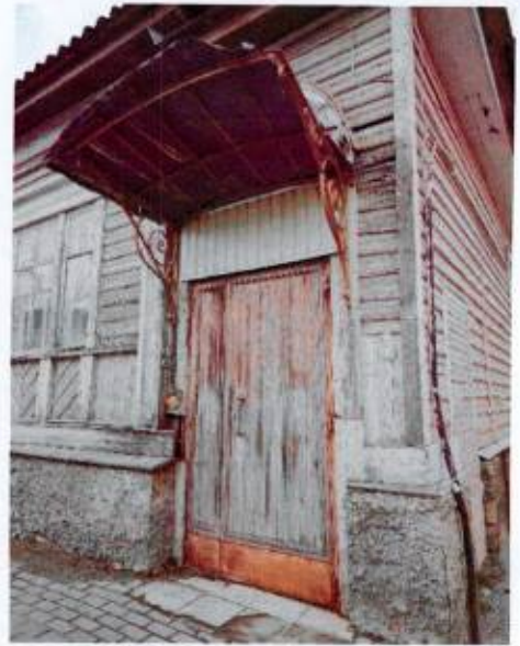
Дверной проем. Лицевой фасад
