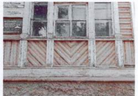
Фрагмент отделки лицевого фасада деревянной профилированной доской
