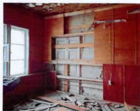
Зашитый дверной проем наружной стены юго-западного дворового фасада. Вид из интерьера
