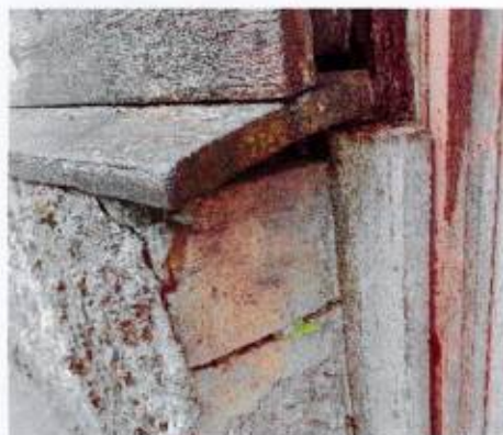
Фрагмент деревянного профилированного отлива над каменным цоколем
