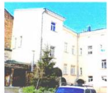
Дворовый фасад южного крыла Торца южного крыла
