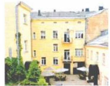
Дворовый фасад западного крыла
