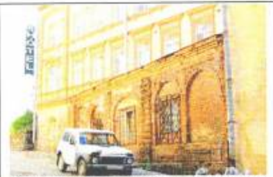
Уличный западный фасад одноэтажной пристройки
