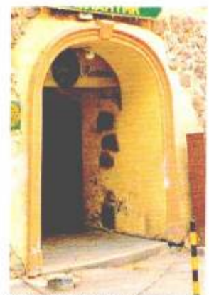
Профильный наличник арочного проема 1-го этажа
