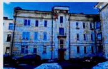
Дворовый С-В фасад Ю-3 крыла
