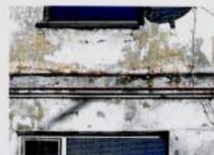
Фрагмент лицевого Ю-З фасада. Межэтажная тяга (между 1-ый и 2-ым этажами)
