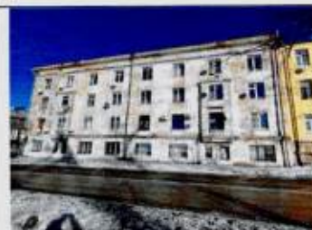
Лицевой Ю-З фасад
