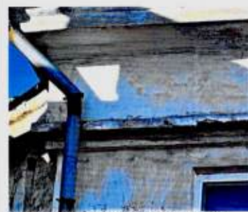
Фрагмент дворового фасада. Первоначальный венчающий карниз
