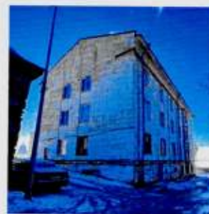
Торцевой С-В фасад С-3 крыла
