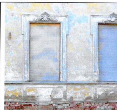
Подоконные филенки (1-ый этаж, С-В лицевой фасад)
