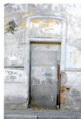
Обрамление уличного дверного проема (Ю-В фасад)
