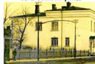
Ю-В боковой фасад. Фото (копия) 1940 г.
