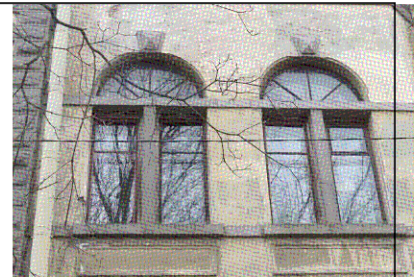
Оформление проемов 2-го этажа (уличные фасады)
