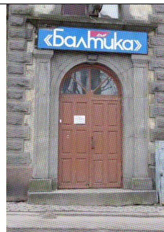
Обрамление портала главного входа (Ю-В фасад)
