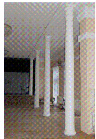
Колонны зала (1-ый этаж)
