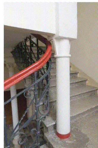
Опорный столб площадки 2-го этажа
