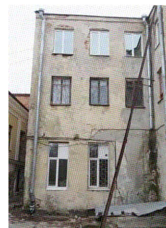
Дворовый юго-восточный фасад западного крыла
