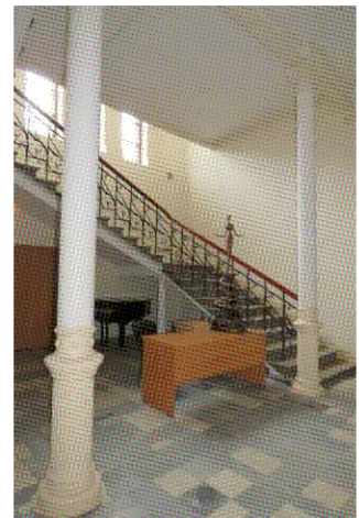
Колонны (холл 1-го этажа)
