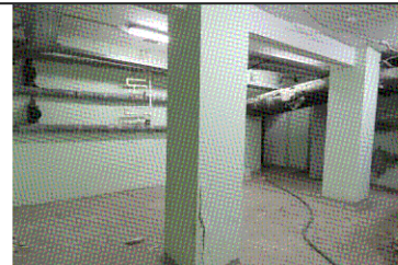
Плоское ж/б перекрытие и опорные столбы (подвал)
