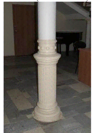
База колонны (холл 1-го этажа)
