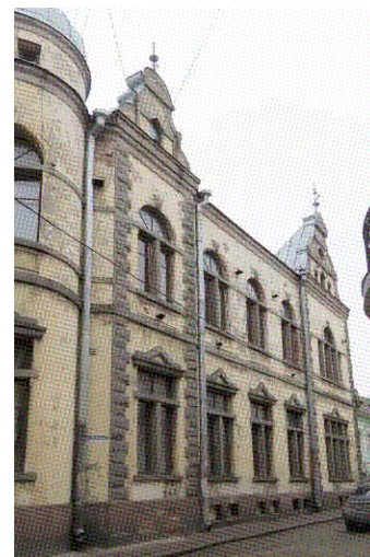
Уличный северо-восточный фасад
