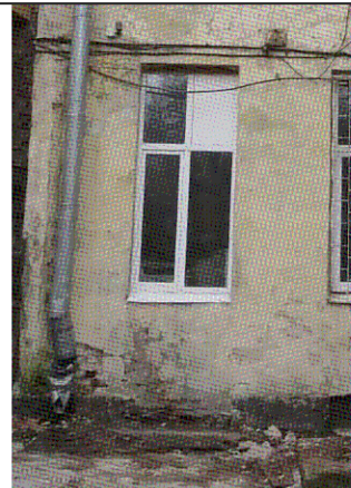
Вход (дворовый Ю-В фасад)
