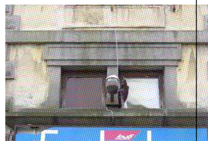
Обрамление проема над входом (Ю-В фасад)
