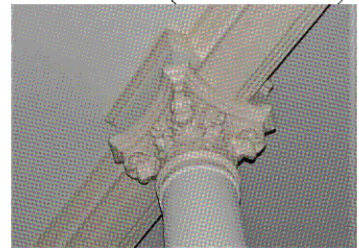
Капитель колонны (холл 1-го этажа)
