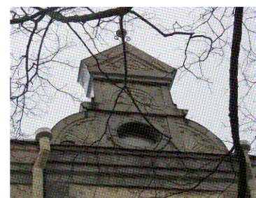
Фронтон (ризалит Ю-В фасада)
