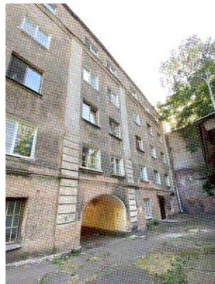
Лопатки (дворовый фасад)
