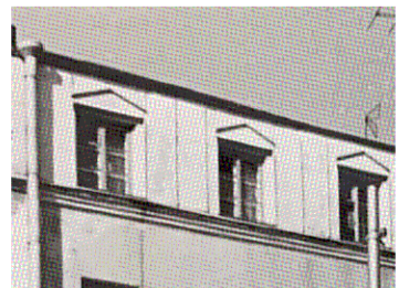
Оформление проемов 5-го этажа (лицевой фасад)
