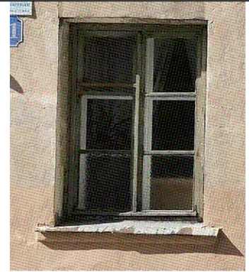
Подоконная тяга (проем 1-го этажа, лицевой фасад)
