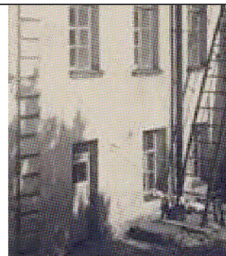
Фрагмент дворового фасада. Фото (копия) 1922 г.
