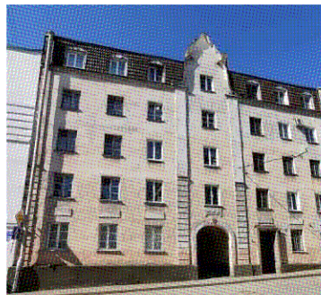
Лицевой С-В фасад
