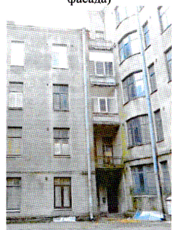
Балконы (С-В дворовый фасад Ю-3 крыла, правая часть)
