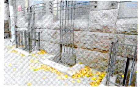
Уличные приемки оконных подвальных проемов
