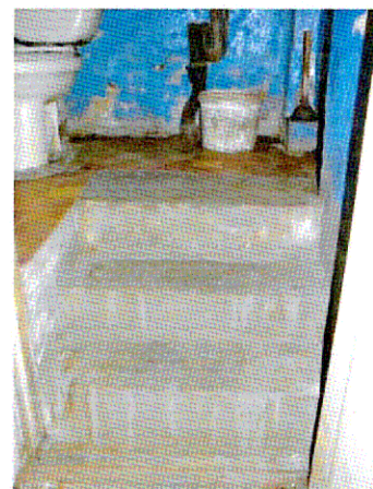
Лестница (помещение в дворовой части уличного корпуса)
