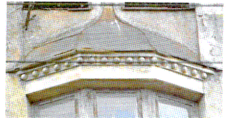
Венчающий карниз трёхгранного окна (лицевой С-3 фасад)
