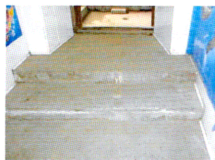
Входные ступени (помещение подвала, уличный корпус)
