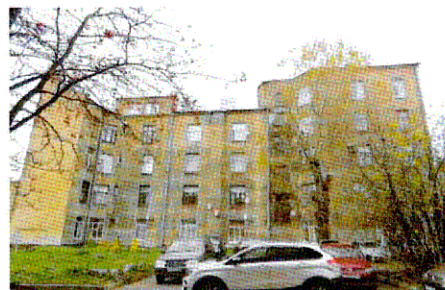
Ю-В фасад Ю-В дворового корпуса
