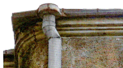
Венчающий карниз (дворовые фасады)
