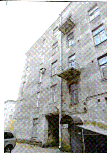
Дворовый С-В фасад С-В крыла. Левая часть
