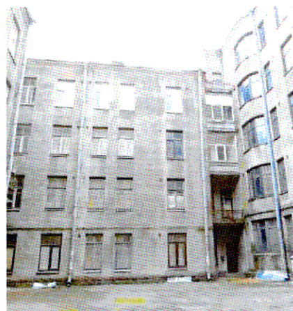
Дворовый С-В фасад Ю-3 крыла
