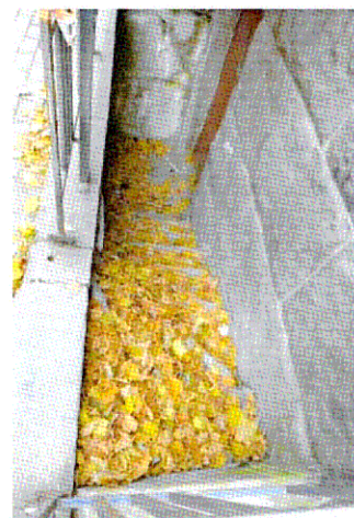
Спуск в подвал в прямке
