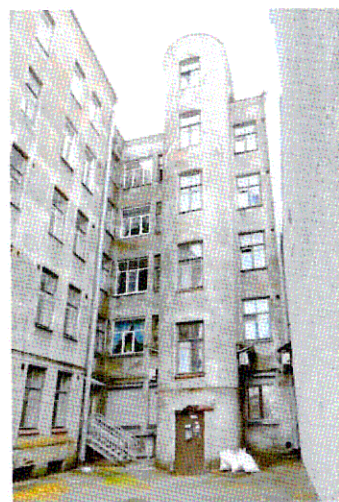
Правая часть дворового Ю-В фасада уличного корпуса
