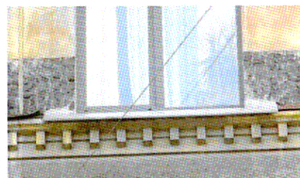
Межэтажный (подоконный карниз). Между 4-ым и 5-ым этажами (лицевой С-З фасад)
