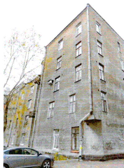
Торцевой Ю-В фасад С-В крыла
