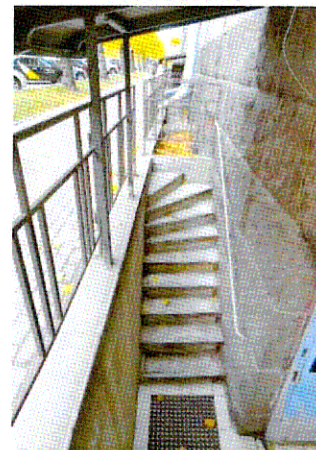
Спуск в подвал в прямке
