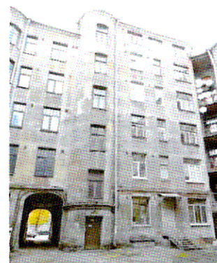
Дворовый Ю-В фасад уличного корпуса
