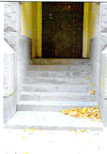
Входная лестница левого уличного входа
