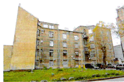
Ю-В фасад Ю-В дворового корпуса
