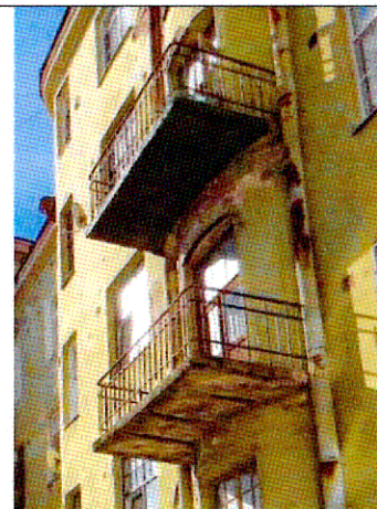
Балконы (Ю-В дворовый фасад)
