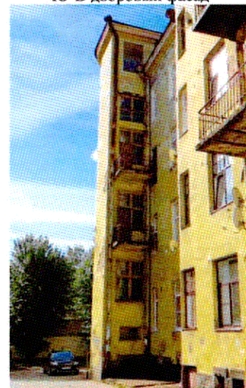
С-В фасад южного ризалита
