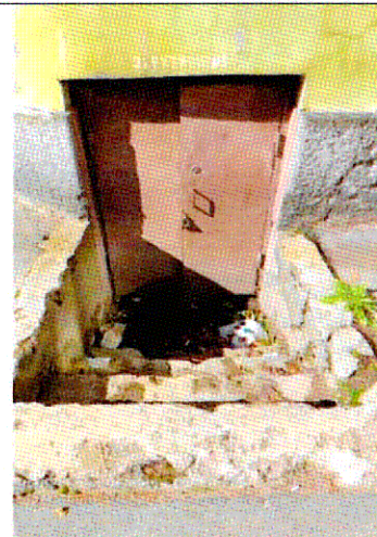
Спуск в подвал (дворовый Ю-В фасад)
