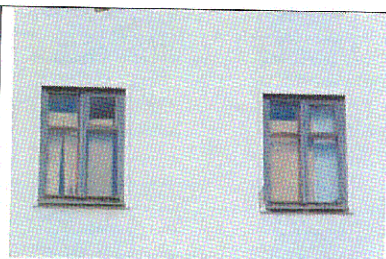
Обрамление проемов 2-го этажа. Лицевой Ю-В фасад
