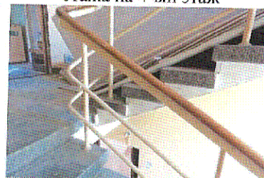
Ограждение лестницы ЛК-1
