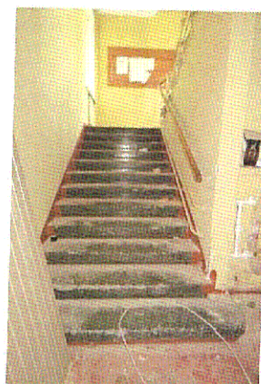
Лестница ЛК-1. Марш 1-го этажа
