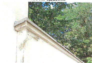
Венчающий карниз ограждающей стены
