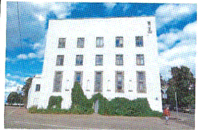
Лицевой Ю-В фасад
