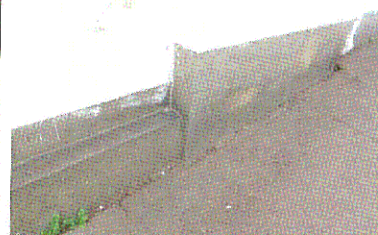
Гранитный цоколь. Уличный С-В фасад
