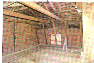
Чердак. Кирпичные стены
