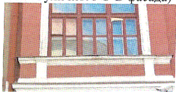
Подоконная тяга (левая часть уличного С-В фасада)
