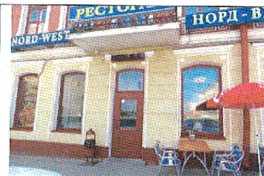
Обрамление проемов 1-го этажа. С-В фасад
