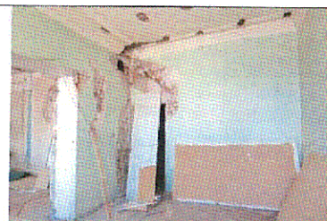
Пом. 2.16. Кирпичные стены
