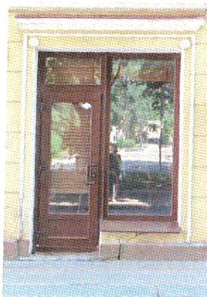
Обрамление проема 1-го этажа. С-З фасад
