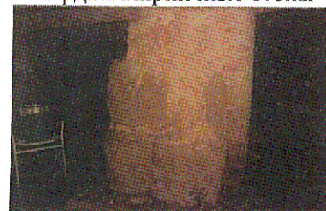
Подвал. Опорный столб из гранита и кирпича (помещение в восточном углу здания)
