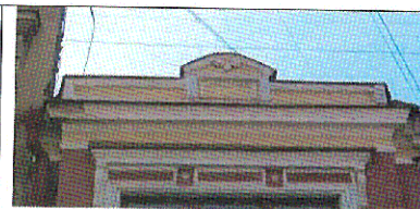
Аттик (левая часть лицевого С-В фасада)
