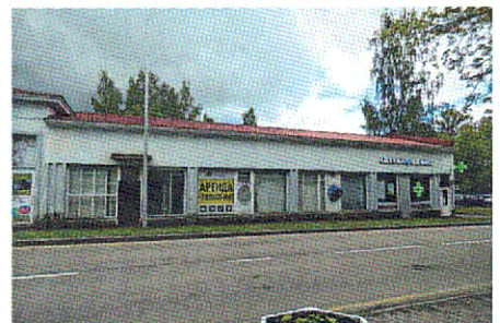
Западная часть лицевого северного фасада
