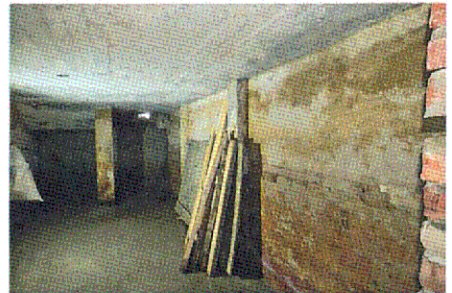
Подвал ((пом. 0.7). Монолитное перекрытие. Опорные столбы
