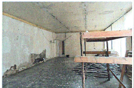
Плоское перекрытие (пом. 1.12)
