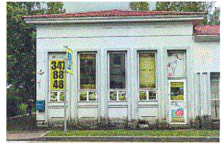
Восточная часть лицевого северного фасада
