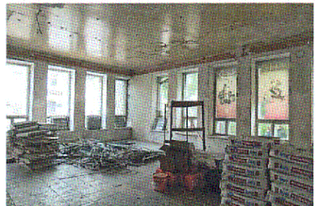
Плоское перекрытие (пом. 1.1)
