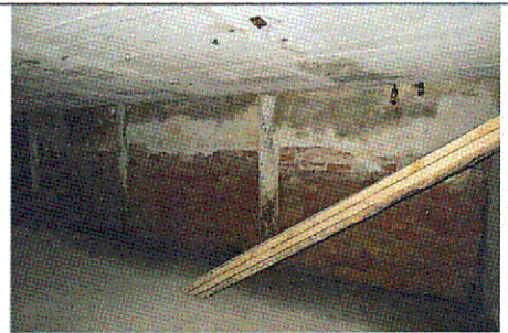
Подвал (пом. 0.5). монолитное перекрытие. Опорные столбы
