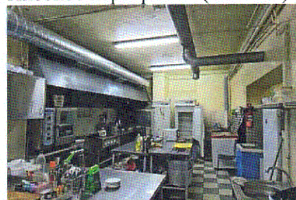
Плоское перекрытие (пом. 0.9)
