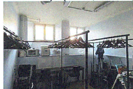
Плоское перекрытие (пом. 0.13)
