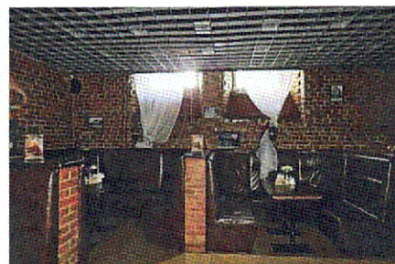
Плоское перекрытие (пом. 0.6)
