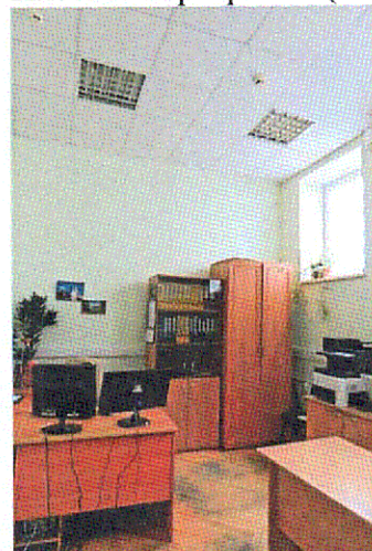
Плоское перекрытие (пом. 1.12)
