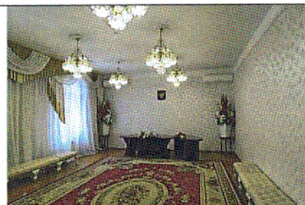
Плоское перекрытие (пом. 1.7)
