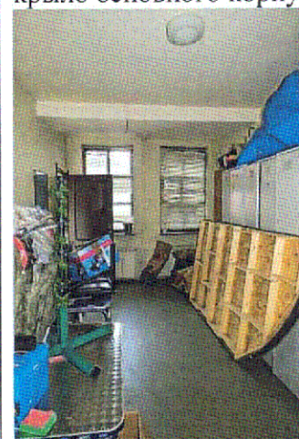
Плоское перекрытие (дворовой корпус)
