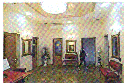
Плоское перекрытие (пом. 1.3)
