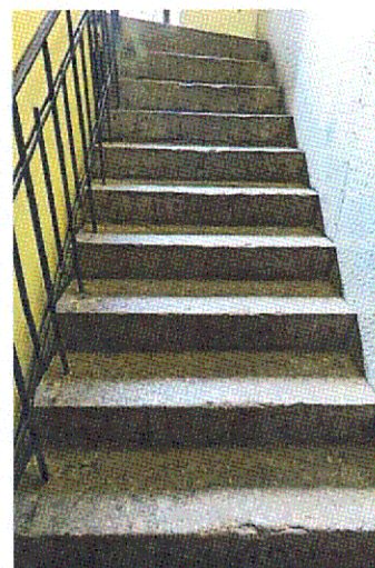
Гранитная лестница (спуск в подвал)
