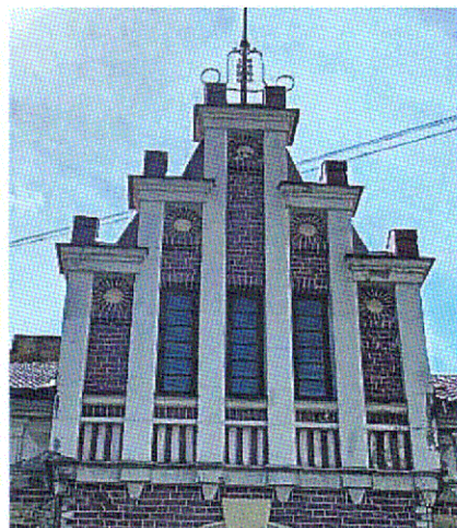
Фронтон (лицевой фасад)
