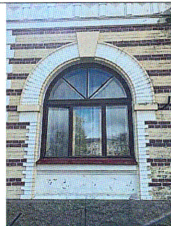
Оконный проем (лицевой фасад)
