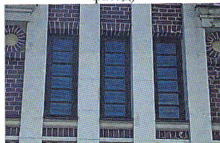
Фронтон. Лицевой фасад
