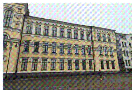
Лицевой С-З фасад. Правая часть
