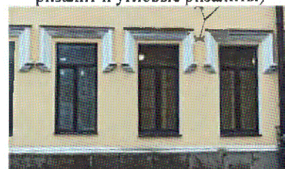
Оконные проемы. 1-ый этаж
