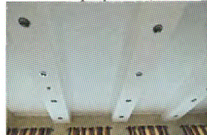
Плоское перекрытие (пом. 1.11)
