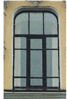
Оконные проемы. Уличные угловые ризалиты. 3-ий этаж
