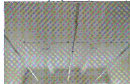
Плоское перекрытие ( пом. 2.22)
