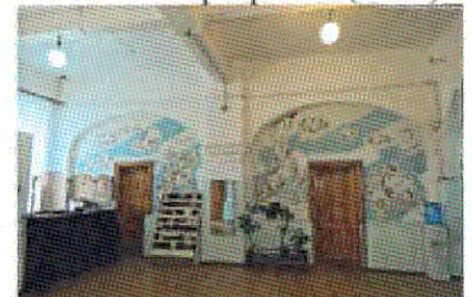
Опорные столбы (между пом. 1.1 и 1.2, 1.3; 1.1 и 1.4)
