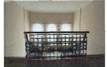
Плоское перекрытие (ЛК-1)
