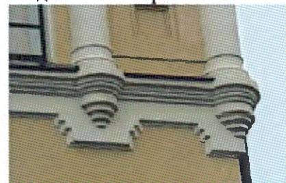
Подоконный карниз. 3-ий этаж
