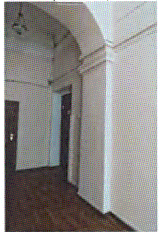
Встроенные опорные столбы (пом. 2.1)
