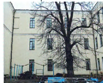
Ю-В фасад. Левая часть
