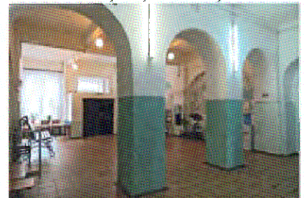
Опорные столбы (между пом. 1.1 и 1.5, ЛК-1)
