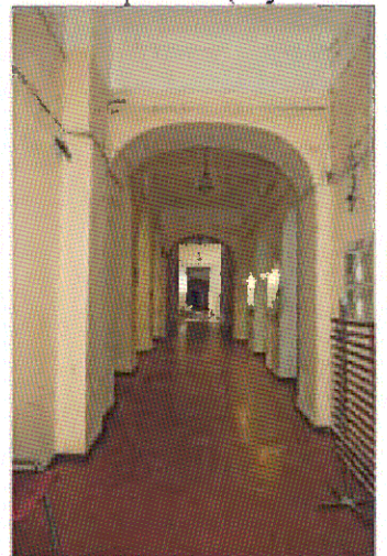
Арочные проемы (пом. 2.1)
