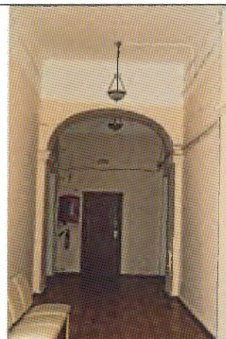
Арочный проем (пом. 2.1)
