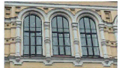
Оконные проемы. 3-ий этаж
