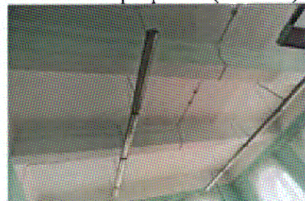
Плоское перекрытие (пом. 2.12).
