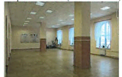
Опорные столбы (пом. 2.6)
