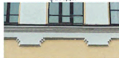
Подоконный карниз. 3-ий этаж
