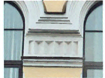
Межоконный пояс. 2-ой этаж
