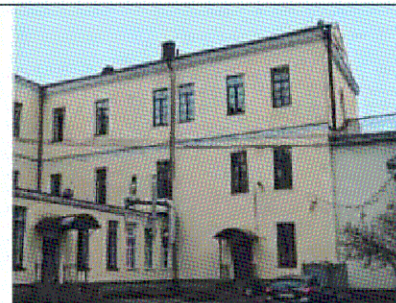
Ю-З дворовой фасад восточного крыла
