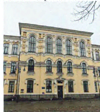
Лицевой С-З фасад. Центральная часть
