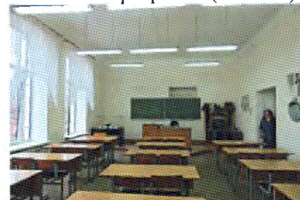
Плоское перекрытие (пом. 3.7)
