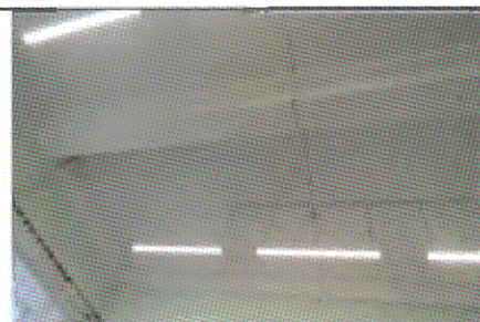
Плоское перекрытие (пом. 2.3)
