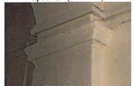
Оформление опорного столба (пом. 2.1)
