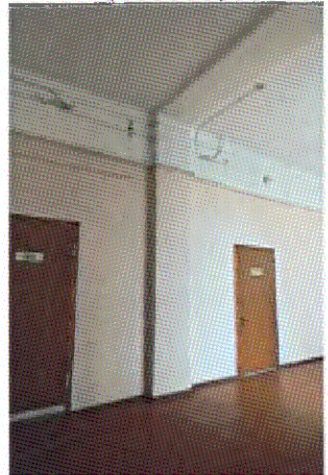
Встроенные опорные столбы (пом. 3.3)
