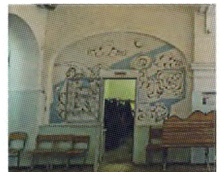
Арочные проемы (между пом. 1.1 и 1.2 – 1.4)
