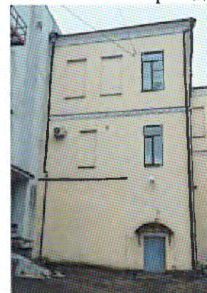
Ю-В дворовой фасад южного ризалита
