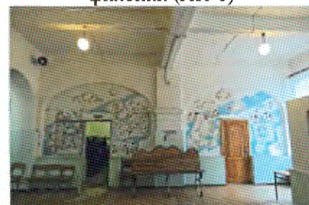
Декоративные опорные столбы арочных проемов (пом. 1.1)
