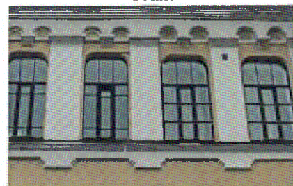
Оконные проемы. 3-ий этаж
