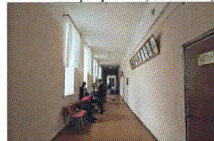
Плоское перекрытие (пом. 3.3)
