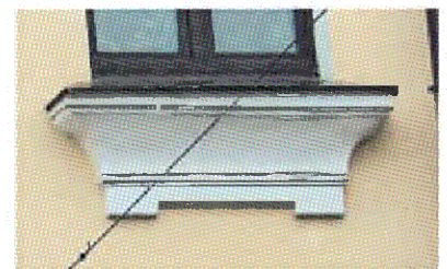
Подоконная тяга. 3-ий этаж
