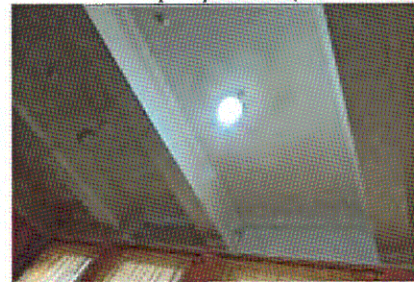
Плоское перекрытие (пом. 1.12)
