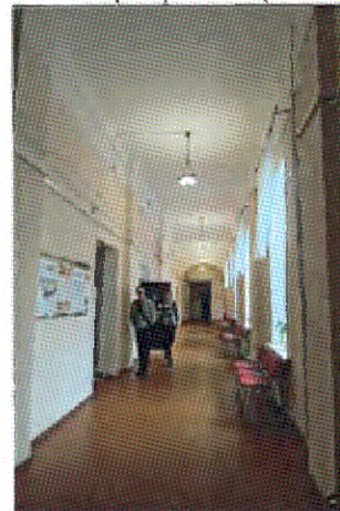
Плоское перекрытие (пом. 2.1)
