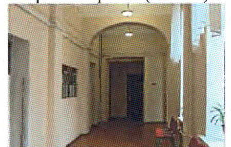
Арочный проем (пом. 2.1)
