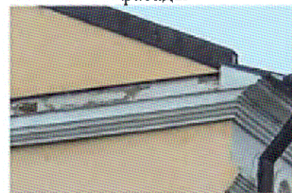
Карниз. Ю-В боковой фасад.
