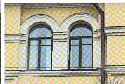
Уличный Ю-В фасад. Проемы 3-го этажа центрального ризалита
