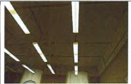
Плоское перекрытие ( пом. 2.12)
