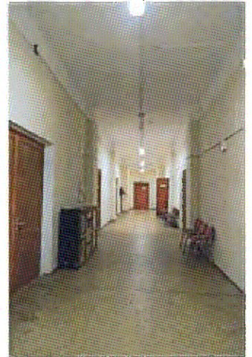
Плоское перекрытие (пом. 3.8)
