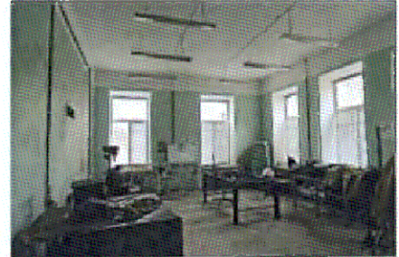
Плоское перекрытие (пом. 1.13)
