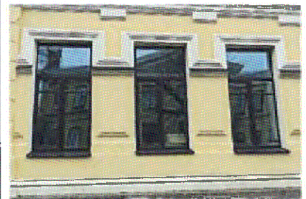
Уличный Ю-В фасад. Проемы 1-го этажа боковых частей фасада
