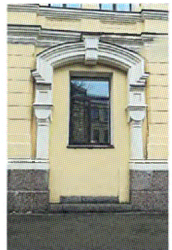
Уличный Ю-В фасад. Главный вход
