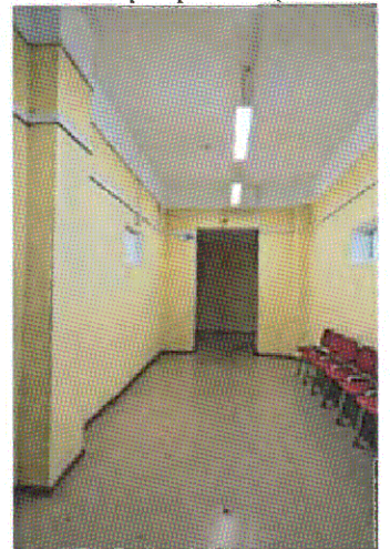
Плоское перекрытие (пом. 2.8)
