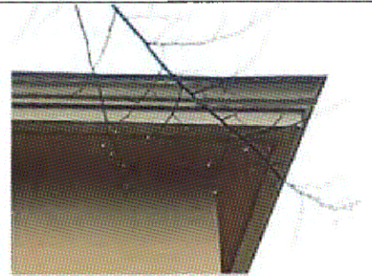
Венчающий карниз. Дворовые фасады
