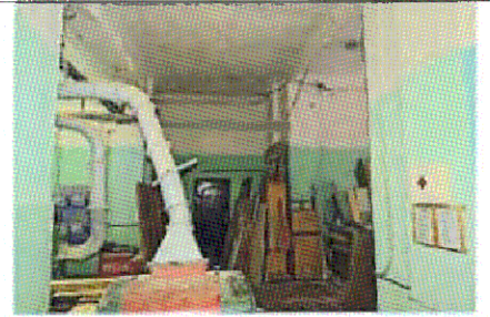
Плоское перекрытие (пом. 1.7)
