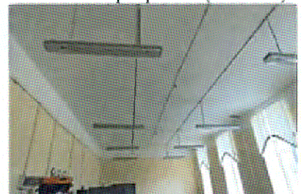
Плоское перекрытие (пом. 2.14).
