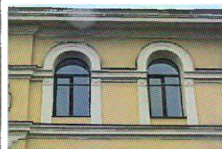
Уличный С-В фасад. Проемы 3-го этажа
