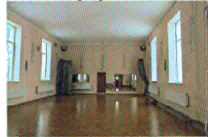
Плоское перекрытие (пом. 2.1)
