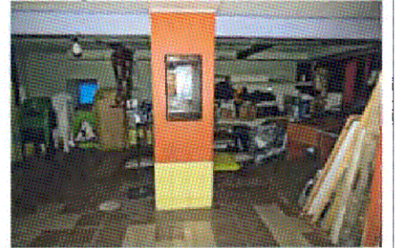
Опорный столб (пом. 0.14)
