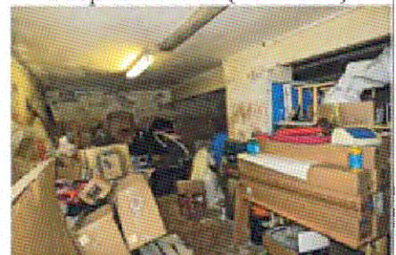
Опорный столб (пом. 0.19)
