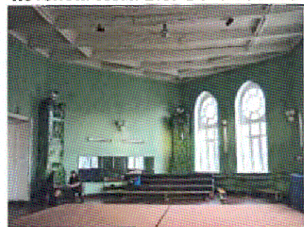
Кессонный деревянный потолок. Пом. 2.3. Фото 2008 г.
