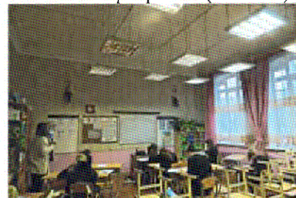
Плоское перекрытие (пом. 1.6)
