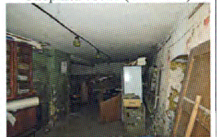
Опорный столб (пом. 0.21)
