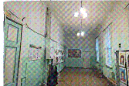
Плоское перекрытие (пом. 1.3)
