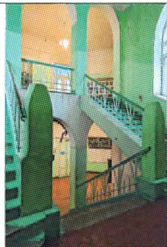
Ограждение лестниц Л-9 – Л-11
