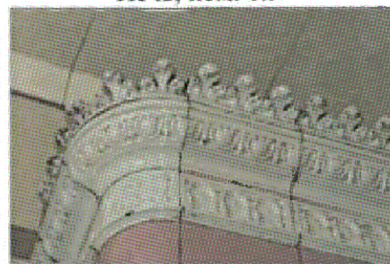
Венчающий карниз печи, пом. 1.9
