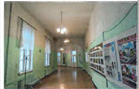
Плоское перекрытие ( пом. 2.2)
