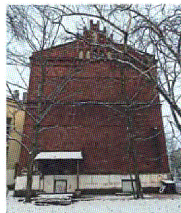
Ю-З торцевой фасад южного крыла
