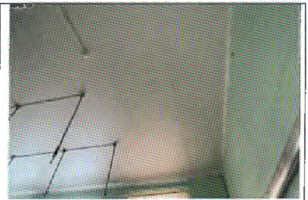
Гладкая штукатурка потолка. Пом. 2.5
