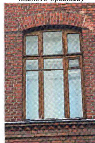
Оконный проем (2-ой этаж, С-З уличный фасад). Историческая расстекловка
