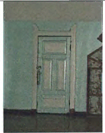
Дверь между пом. 2.2 и 2.6. Фото 2008 г. (утрачена, восстановление)
