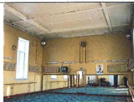
Кессонный деревянный потолок. Пом. 2.1. Фото 2008 г.
