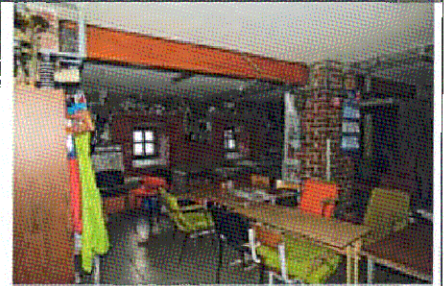
Опорные столбы (пом. 0.10)
