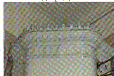
Венчающий карниз печи, пом. 1.10
