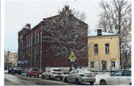
Общий вид здания с северо-запада
