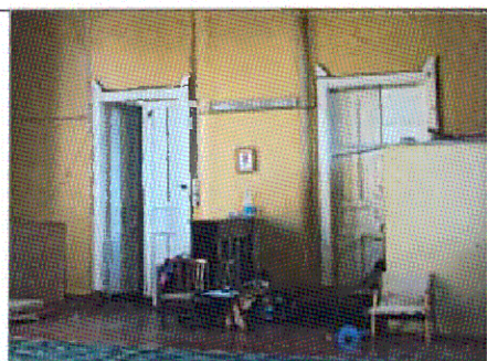
Двери между пом. 2.1 и главной лестницей. Фото 2008 г. со стороны пом. 2.1 (утрачены, требуется восстановление)
