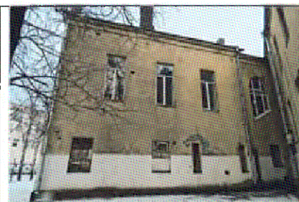
Южный фасад дворового западного крыла
