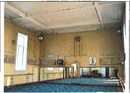
Плоское перекрытие (пом. 2.1). Фото 2008 г.
