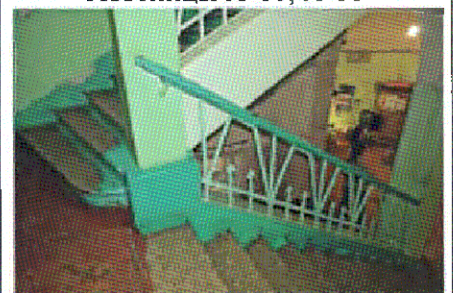
Ограждение лестниц Л-9 – Л-11
