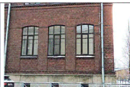
Оконные проемы (1-ый этаж, уличные фасады)
