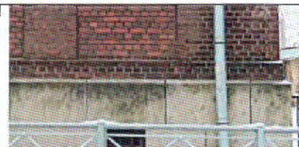
Английская кладка (пояс уличных фасадов)
