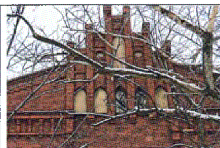
Щипец (Ю-З торцевой фасад южного крыла)
