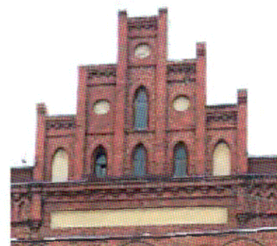
Оконные проемы фронтона (чердак). Восточный фасад
