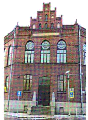
Лицевой восточный фасад
