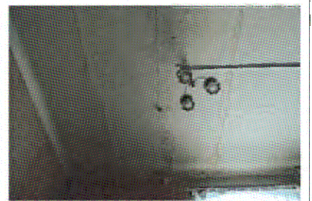
Плоское перекрытие (пом. 2.4)
