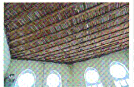
Плоское перекрытие (пом. 2.3)
