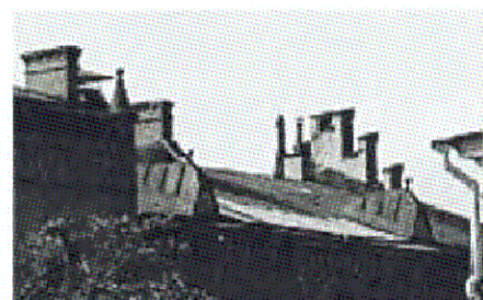
Исторические слуховые окна и вентшахты. Фото 1941 г.
