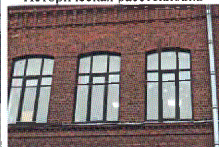
Оконные проемы (2-ой этаж, уличные фасады северного и южного крыльев)
