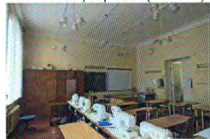
Плоское перекрытие (пом. 1.12)
