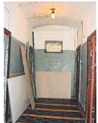
Сводчатое перекрытие (пом. 1.14). Фото 2008 г.
