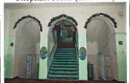
Опорные столбы (пом. 1.3)
