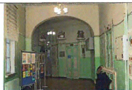
Арочный проем. Пом. 1.3
