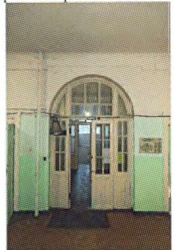
Арочный проем. Пом. 1.3
