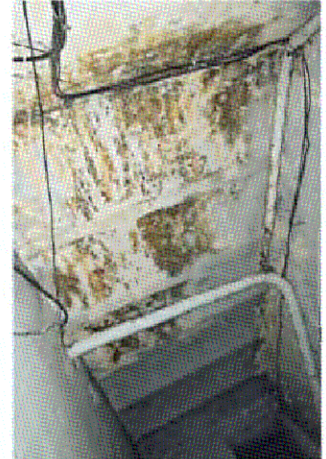
Кирпичные сводики по металлическим балкам (Л-12)
