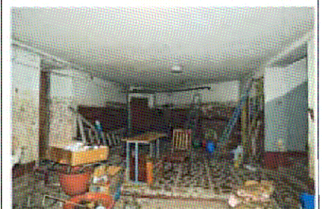
Перекрытие (подвал, пом. 0.1)
