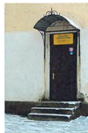
Входы (северный фасад западного крыла)
