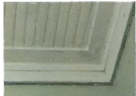
Деревянная галтель. Пом. 1.5
