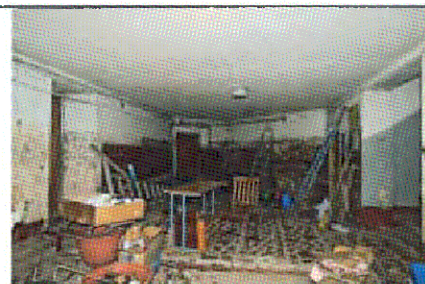
Перекрытие (подвал, пом. 0.8)
