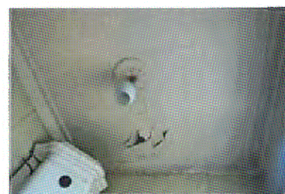
Плоское перекрытие (пом. 2.1)
