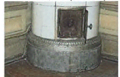
Основание и дверца печи (пом. 2.4)
