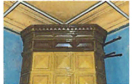
Венчающий карниз печи (пом. 1.13)
