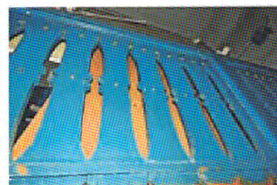
Деревянное ограждение (пом. 2.18)
