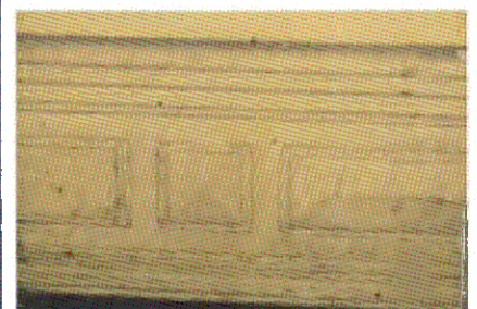
Рельефный декор оформления нижней части стен (пом. 1.1)
