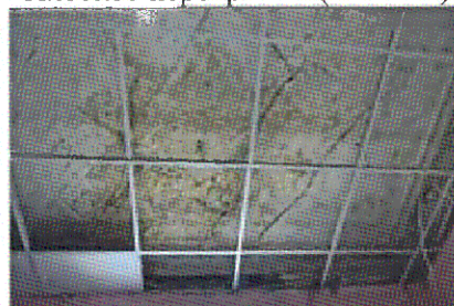
Плоское перекрытие (пом. 1.13)
