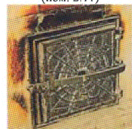
Дверца топки печи (пом. 2.11), фото 2003 г.
