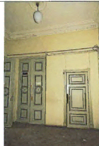
Деревянные двери (пом. 2.1)
