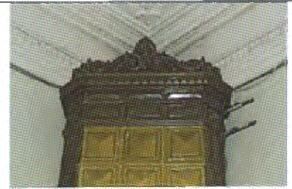
Венчающий карниз печи (пом. 2.10)
