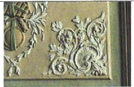
Лепной декор филенок стены (пом. 2.4, фрагмент)
