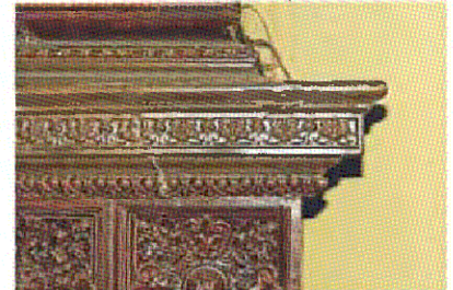
Карниз основания печи (пом. 2.6)
