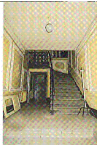
Плоское перекрытие (пом. 1.1)
