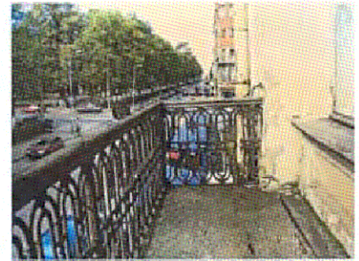
Балкон (Ю-З лицевой фасад)
