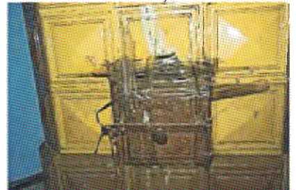
Дверца топки печи (пом. 1.13)
