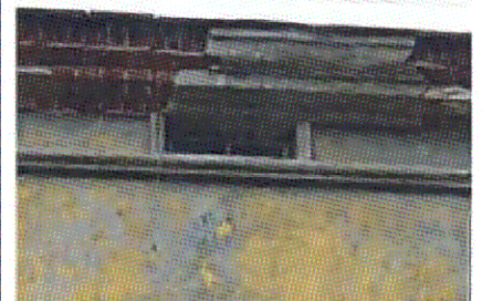
Оконный проем (фриз, дворовые фасады)
