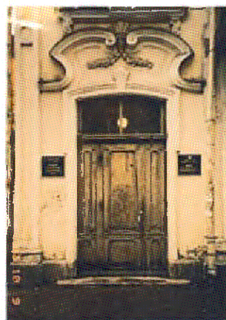
Входной проем, его оформление (Ю-3 лицевой фасад), фото 2003 г.
