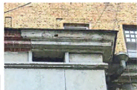
Венчающий карниз (дворовые фасады)
