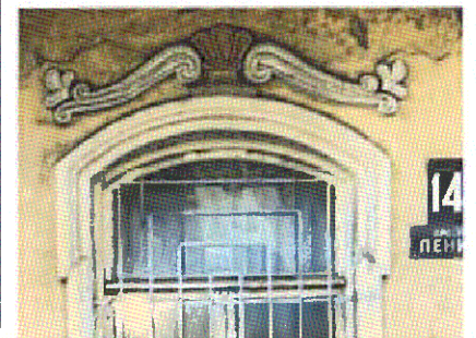
Сандрик проема (Ю-З лицевой фасад, центральная часть, 1-ый ярус), фото 2006 г.
