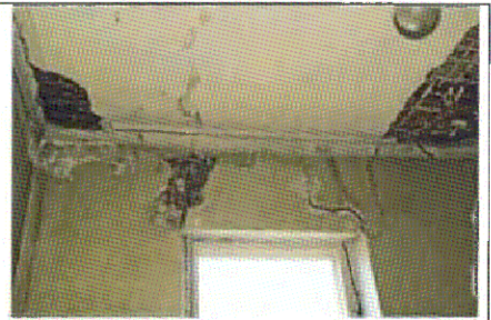
Плоское перекрытие (пом. 2.3)
