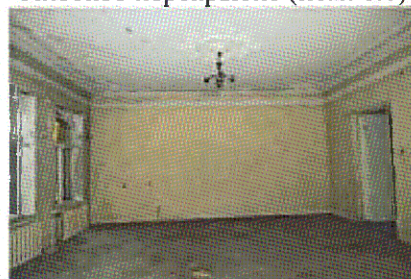
Плоское перекрытие (пом. 1.8)
