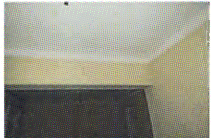
Поточная галтель (пом. 1.9, пом. 2.3, 2.7, 2.11, 2.12)
