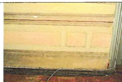
Оформление парапета (пом. 2.4, нижняя часть стен)
