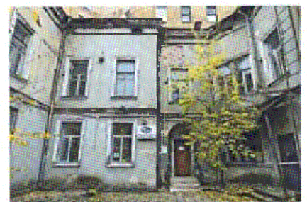
Дворовой С-З фасад дворового крыла
