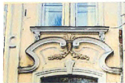
Фигурный сандрик проемов 1-го яруса, подоконная тяга проемов 2-го яруса (Ю-3 лицевой фасад) Фото 2006 г.
