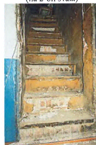
Лестница кирпичная (на чердак)
