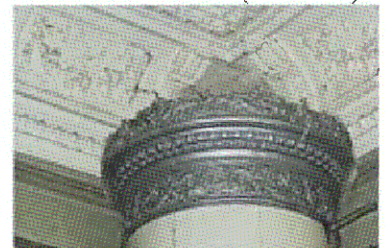
Венчающий карниз печи (пом. 2.4)
