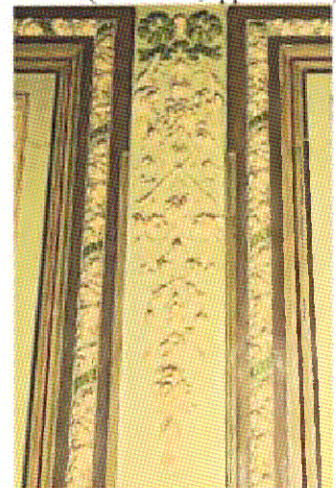
Лепной декор простенка между филенками (пом. 2.4, фрагмент)
