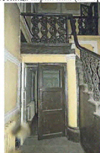
Опорная полуколонна (пом. 1.1, 1-ый ярус)
