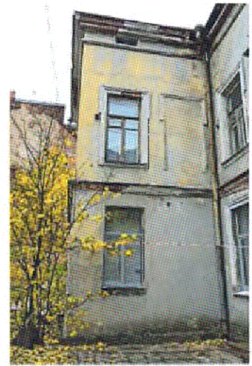
Дворовой Ю-З фасад дворового крыла
