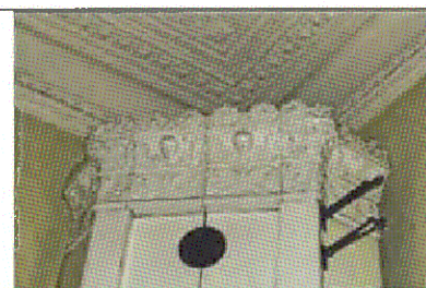
Венчающий карниз печи (пом. 2.5)
