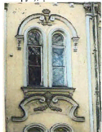
Сандрик проемов (Ю-З лицевой фасад, 2-ой ярус), фото 2006 г.
