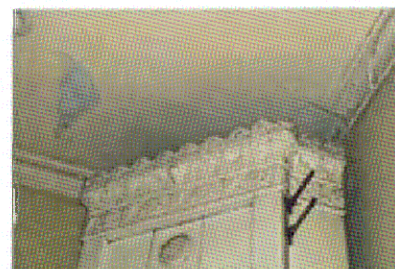
Венчающий карниз печи (пом. 2.3)
