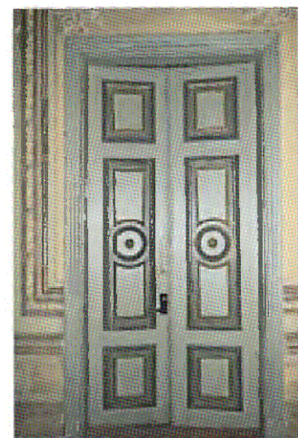
Деревянная дверь (пом. 2.4, 2.5, 2.6)
