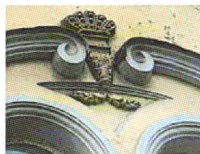
Центральная часть сандрика проемов Ю-3 лицевого фасада, 2-ой ярус (ризалиты), фото 2006 г.
