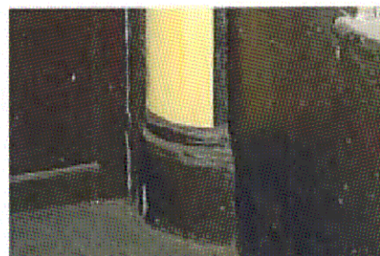
База полуколонны (пом. 1.1, 1-ый ярус)
